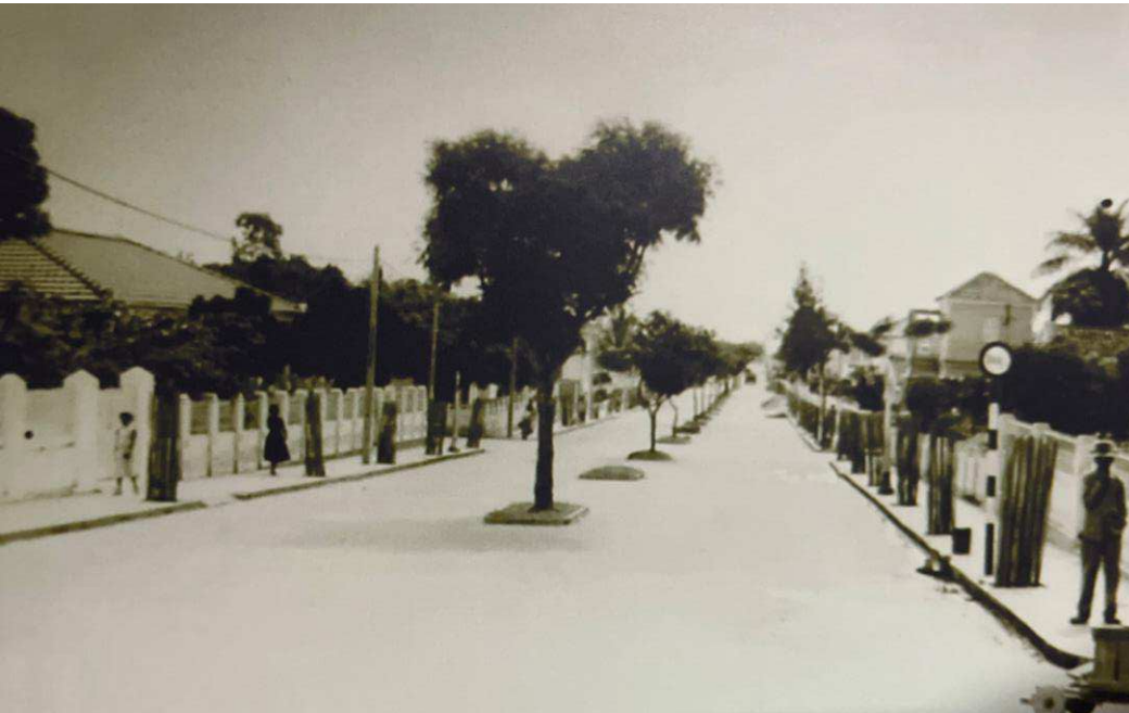
Figura 40: Ambiente Urbano rua João da Mata
