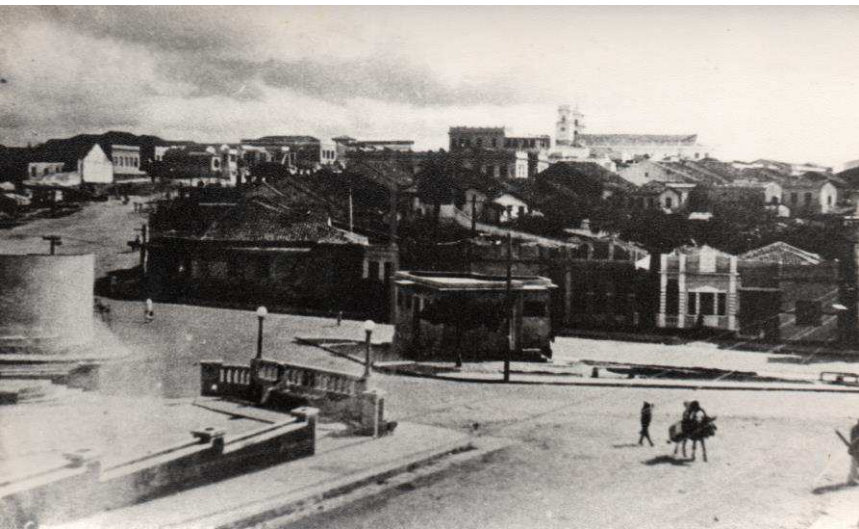
Figura 25: R. Venâncio Neiva anos 40. Após demolição das “casas de fósforos”
