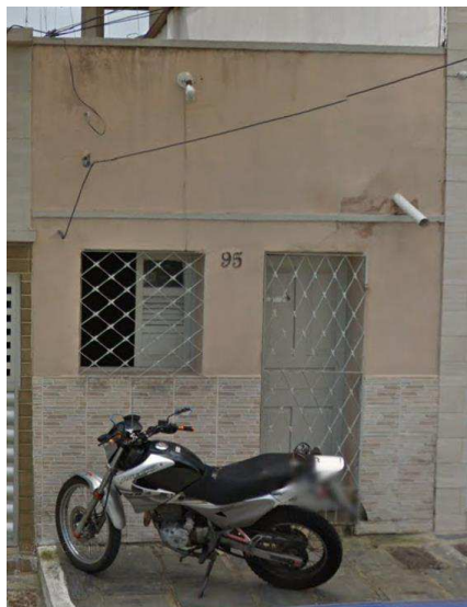
Figura 56: Platibanda com revestimento em Cal e tinta Fonte: Street View
