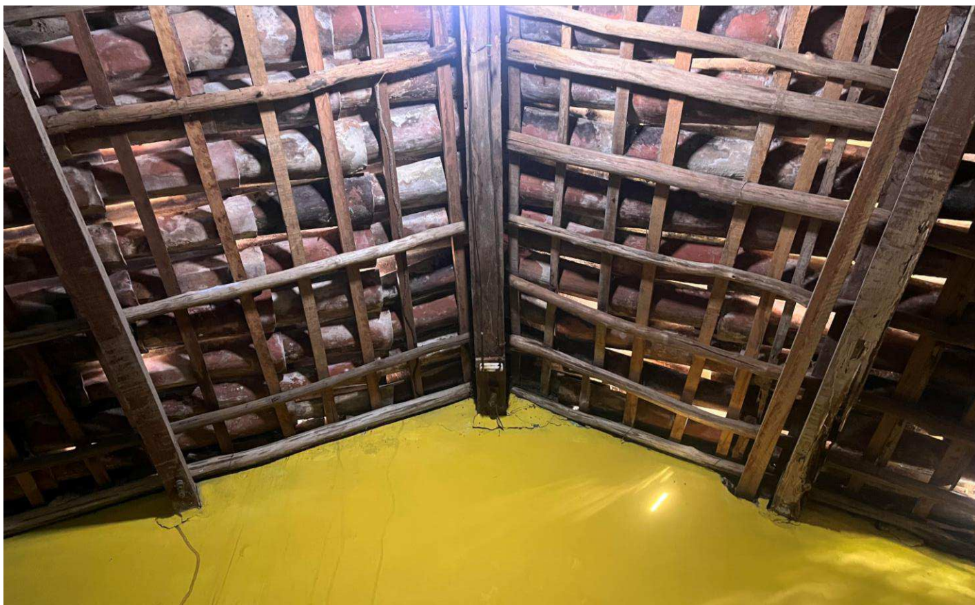
Figura 54: Estrutura casa do Beco da Pororoca
