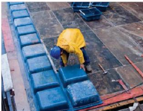
Figura 14 - Cubetas distribuídas sobre fôrmas de madeira
