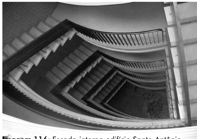
Imagem 116: Escada interna edifício Santo Antônio
