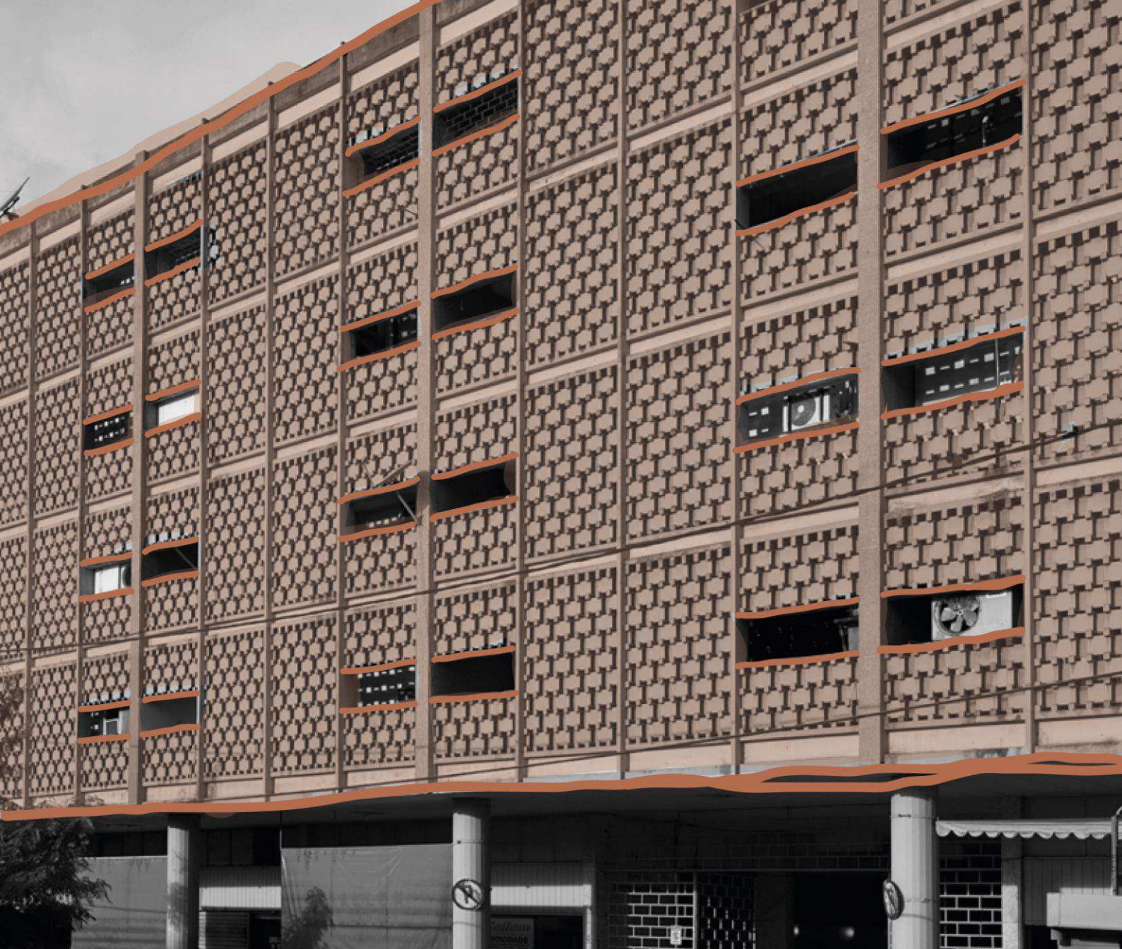
Imagem 42: Película de cobogós. Indicação: caixilhos retangulares de concreto Fonte: Disponível em : https://revistacontinente.com.br/ . Editado pela autora, 2022.
