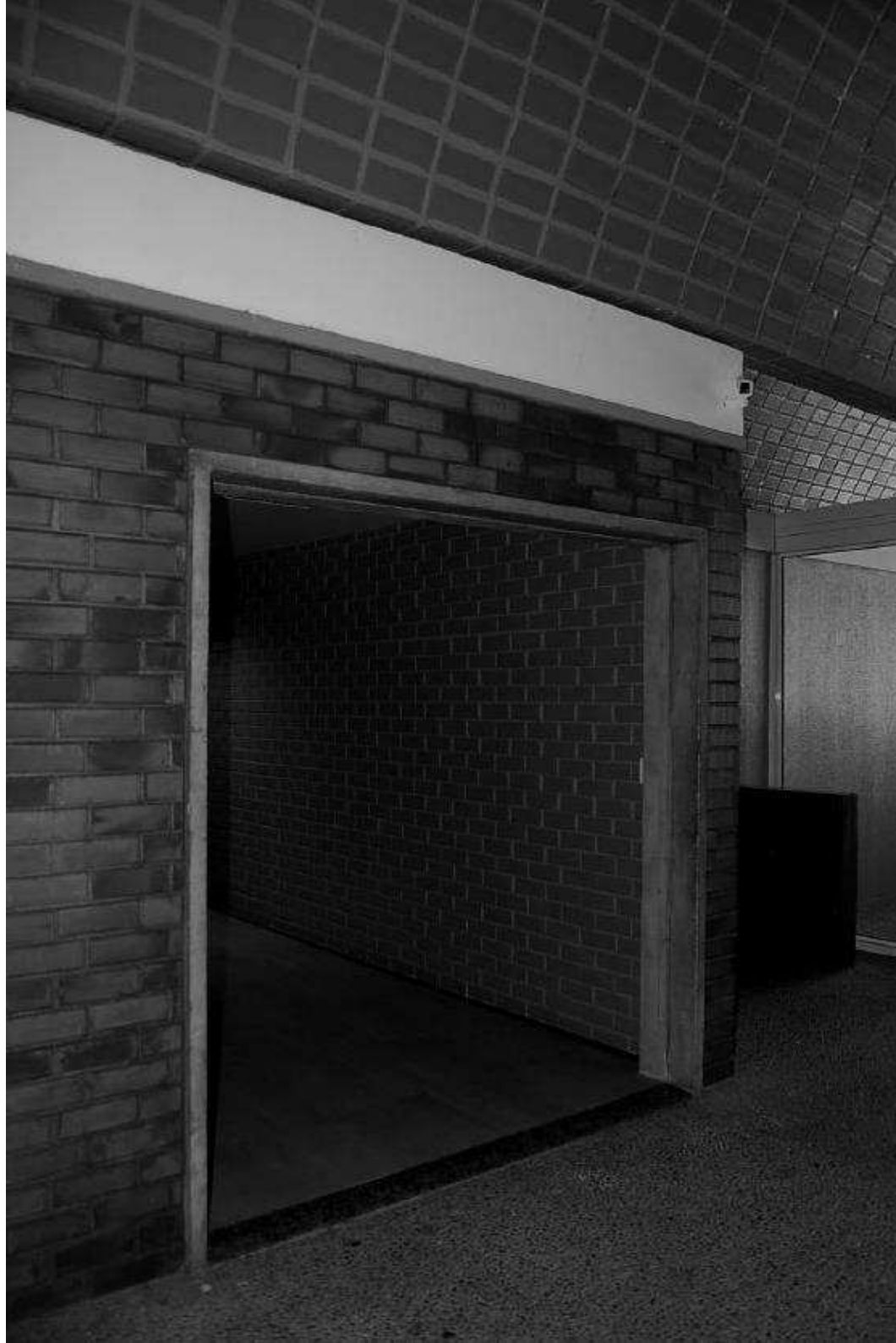
Imagem 101: Texturas das paredes, piso e coberta Fonte: Ana Rosa Negreiros, 2012. Editado pela autora, 2022.
