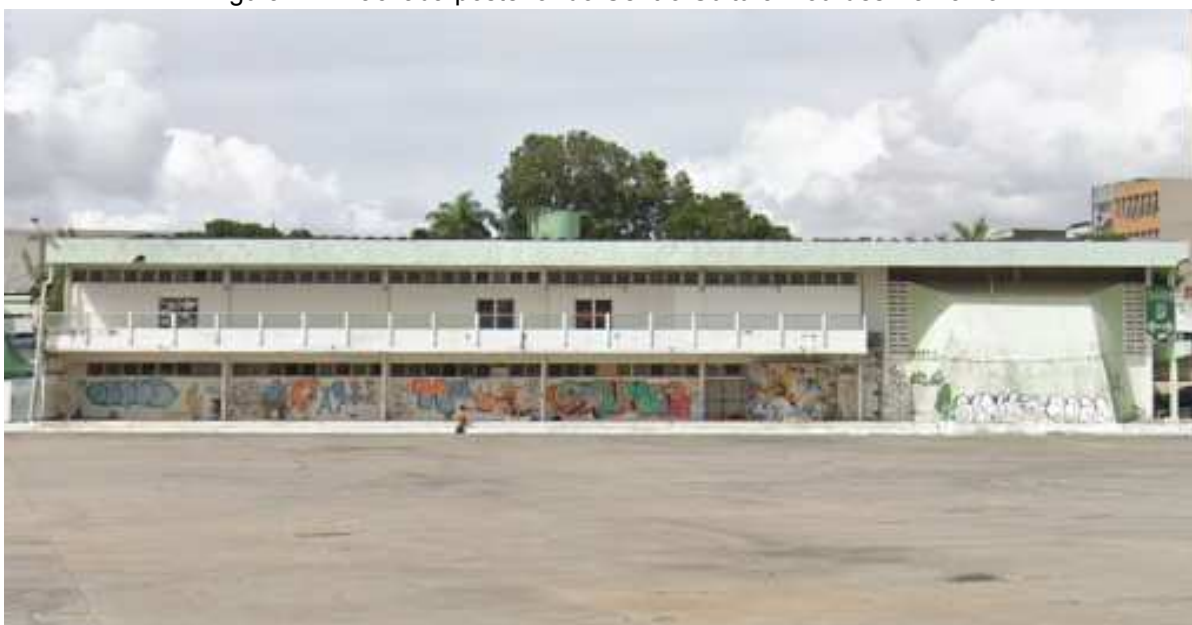
Figura 24 - Fachada posterior do Centro Cultural Lourdes Ramalho
