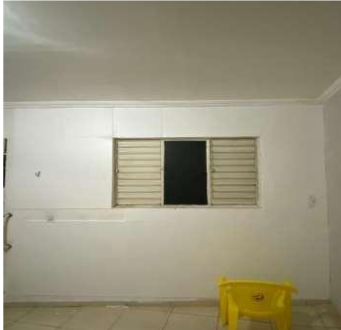
Figura 15 - Parte interna da fachada parcialmente revestida com EPS
