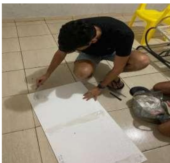
Figura 12 - Aplicação de massa corrida nas placas de EPS
