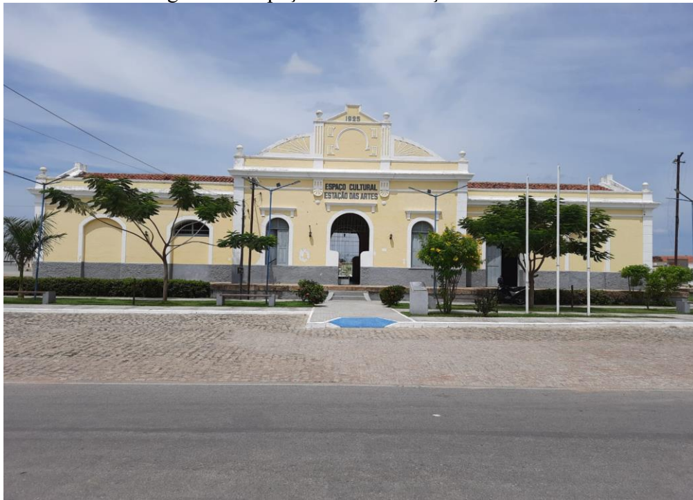
Figura 2 – Espaço Cultural Estação das Artes
