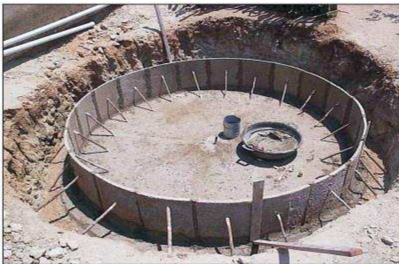
Figura 4. Montagem da primeira fileira de placas. Fonte: França (2010).
