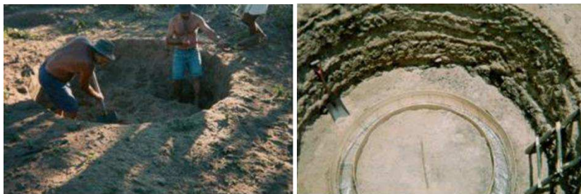
Figura 2. Escavação e início da moldagem da sapata cortante.
