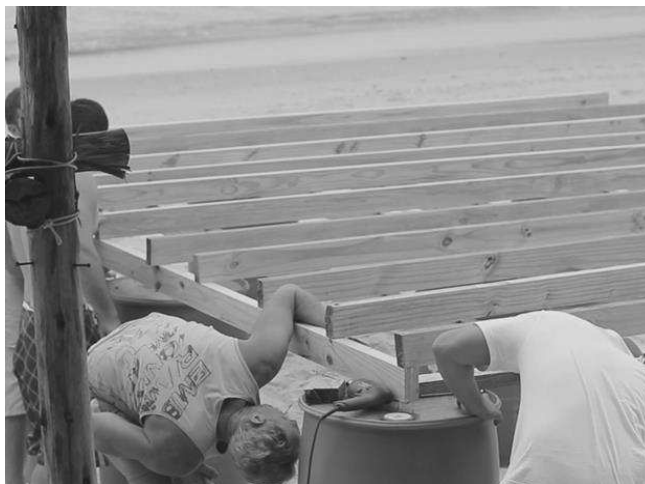
Figura 4. Posicionamento dos barris na estrutura. Fonte: Mallon (2012).
