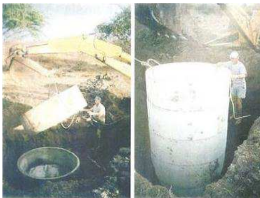
Figura 2. Instalação dos anéis sobrepostos.
