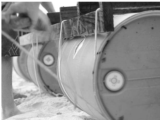
Figura 5. Conclusão da amarração dos barris da estrutura.
