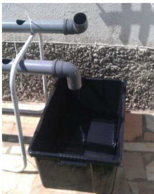
Figura 3. Instalação da entrada e saída de água.
