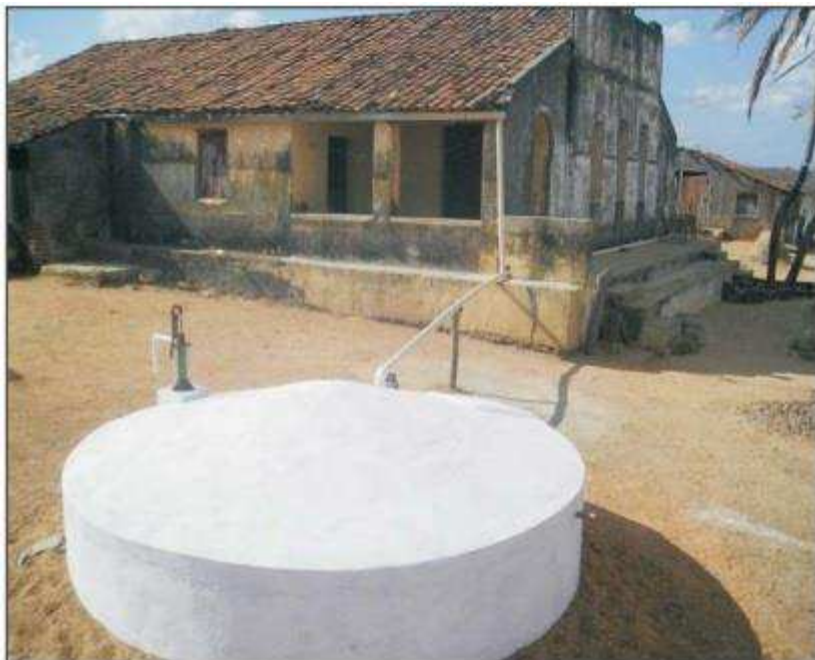
Figura 9. Cisterna de placas finalizada. Fonte: França (2010).
