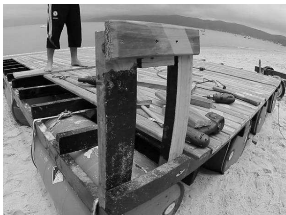
Figura 6. Estrutura pronta. Fonte: Mallon (2012).
