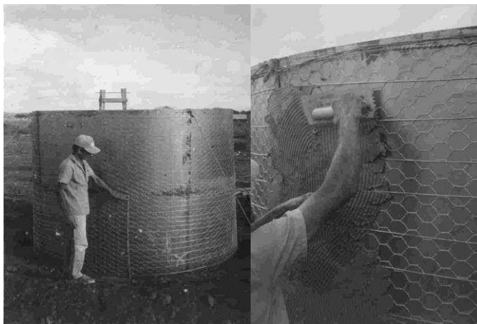
Figura 2. Montagem da tela e acabamento. Fonte: Schistek (2014).
