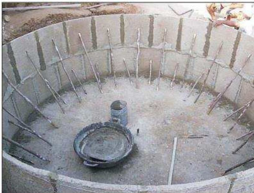
Figura 5. Detalhes da montagem da segunda fileira de placas.
