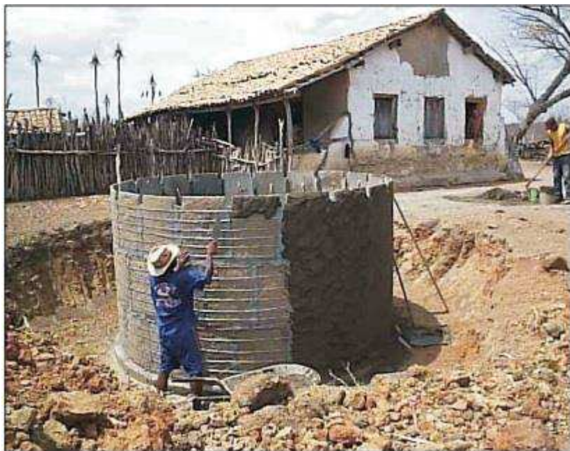
Figura 8. Aspectos do reboco externo da cisterna.
