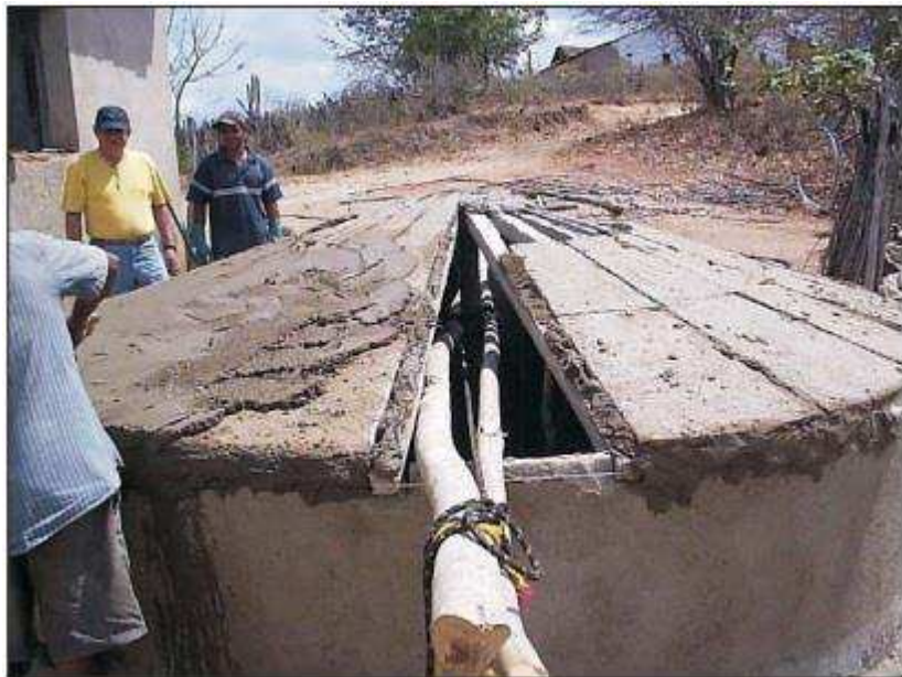
Figura 7. Detalhes da montagem da tampa da cisterna.
