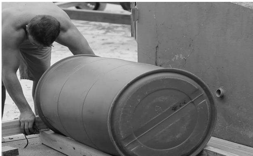
Figura 3. Amarração dos barris na estrutura. Fonte: Mallon (2012).
