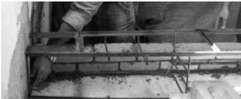
Figura 4. Montagem do fogão. Fonte: CAATINGA (2014).
