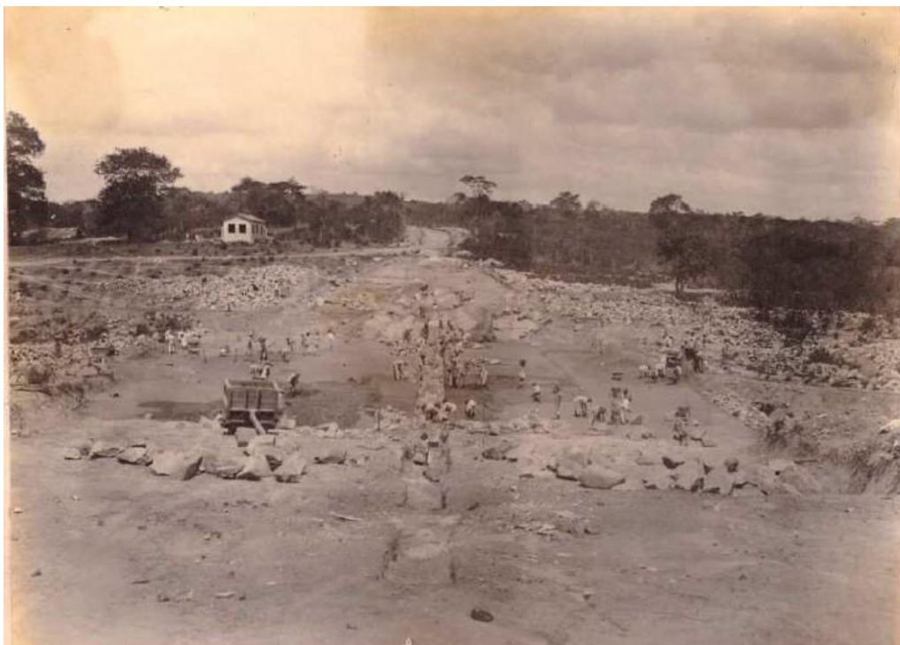
Imagem 06 – Vista geral das obras (março de 1916). Acervo DNOCS/Coordenadoria Estadual na Paraíba (João Pessoa)
