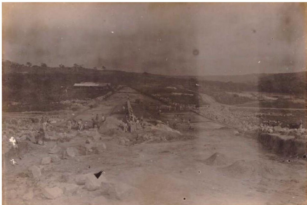
Imagem 07 – Núcleo de alvenaria e progresso do aterro (vista em sentido oeste) (abril de 1916). Acervo DNOCS/Coordenadoria Estadual na Paraíba (João Pessoa)
