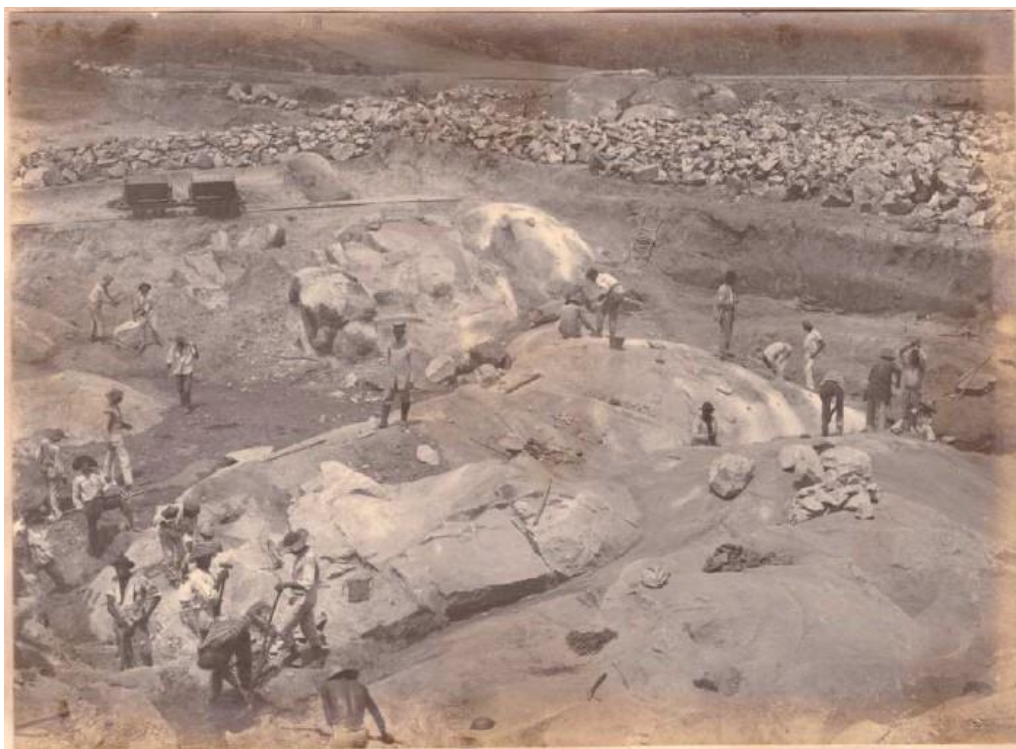
Imagem 03 – Limpeza das galerias e demolição dos blocos de pedra isolados no fundo do riacho para construção dos alicerces da barragem (dezembro de 1915). Acervo DNOCS/Coordenadoria Estadual na Paraíba (João Pessoa)
