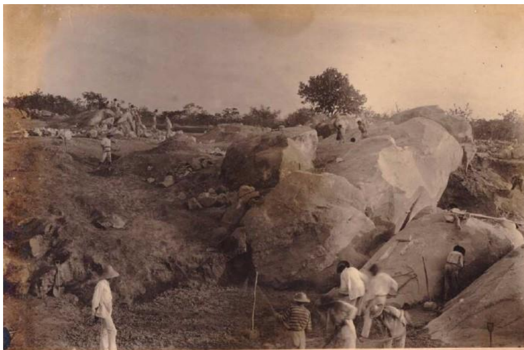
Imagem 04 – Começo do aterro (janeiro de 1916). Acervo DNOCS/Coordenadoria Estadual na Paraíba (João Pessoa)
