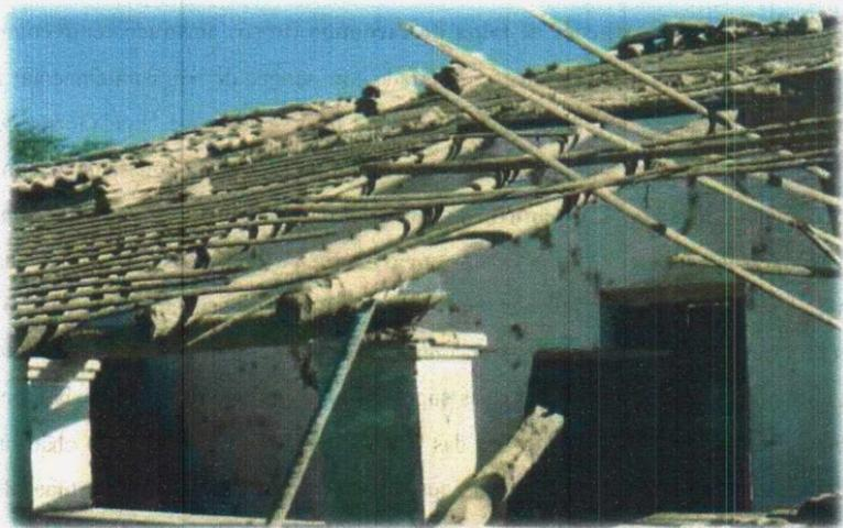
Foto 8 – Vista interna do telhado de uma edificação com mastro de carnaúba
