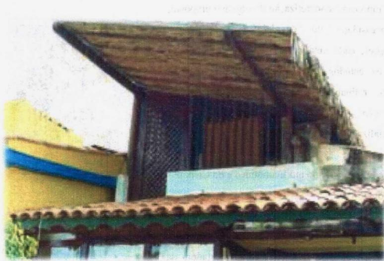
... e a utilização de troncos de carnaúba para a estrutura dos beirais, o que garante a durabilidade da obra, pois a carnaúba não é atacada por cupins. Além disso, a utilização de folhas de carnaúba trançadas para a cobertura proporciona uma excelente estanqueidade e facilidade de manutenção, embora seu emprego exija cautela, por se tratar de material combustível.
