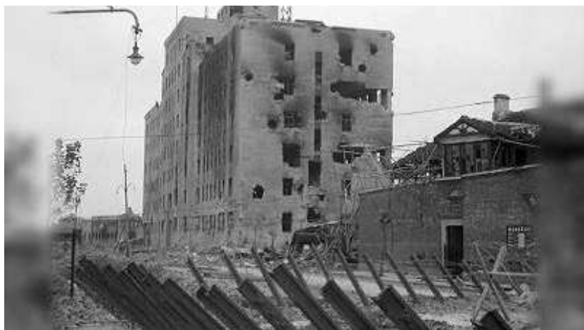
FIGURA 28 – SHANGHAI, 1937: EDIFÍCIOS BOMBARDEADOS POR AVIÕES JAPONESES.
