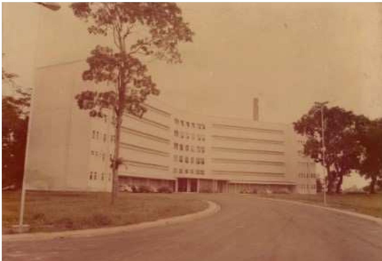
Fachada Oeste (atual entrada principal) com pavimentação asfáltica na via frontal. Fonte: Acervo fotográfico da Biblioteca do HUJBB, s/d
