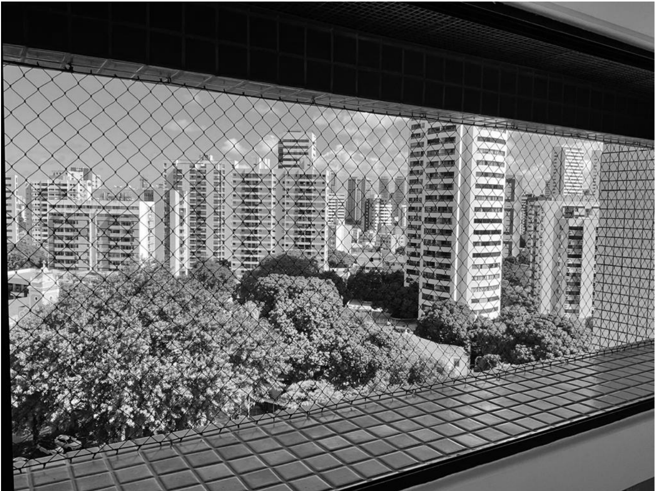
Vista externa do corredor da zona íntima do Edifício Cárpatos (1994). Fonte: Acervo pessoal
