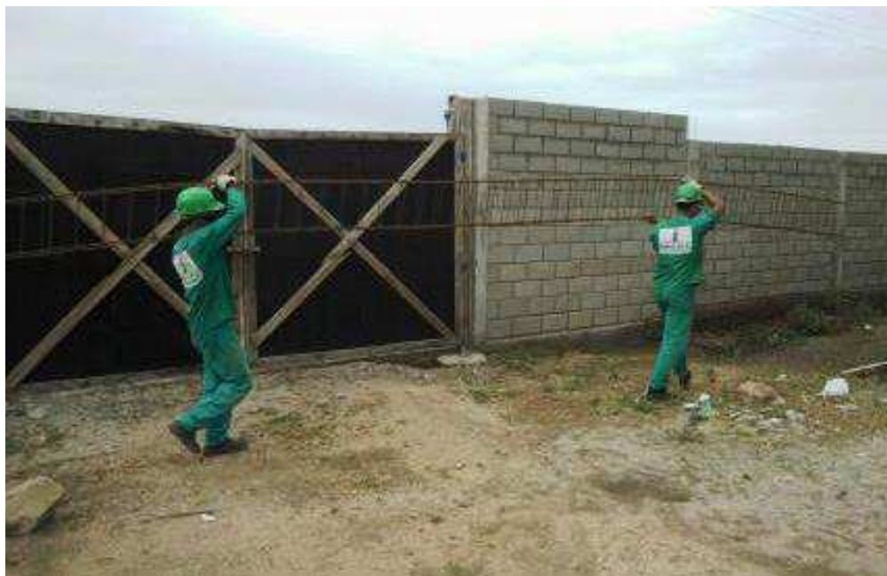
Figura 7 - trabalhadores atuando no posto de trabalho na obra Condomínio Rosa de Sharon
