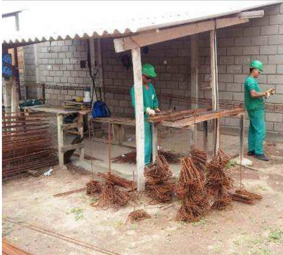
Figura 6 - trabalhadores atuando no posto de trabalho na obra Condomínio Rosa de Sharon
