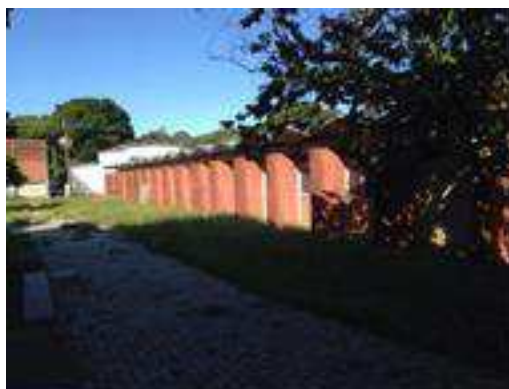
Figura 07: Foto fachada noroeste bloco D.
