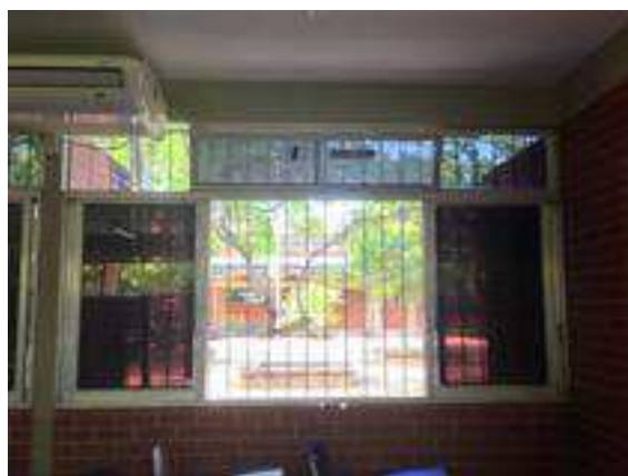
Figura 05: Esquadria sala de aula dos blocos A, B e D.
