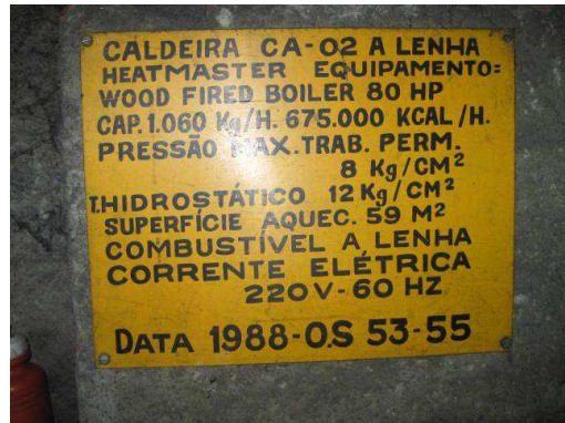
Figura 5 – Placa de identificação da caldeira.
