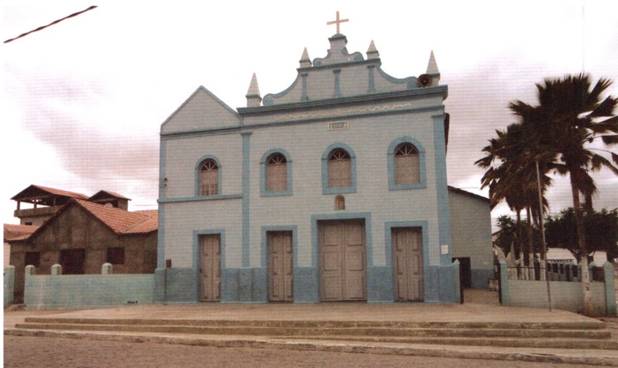
Imagem 1: Vista frontal atual (2013) da Igreja de Nossa Senhora Santana 8 . Ao lado esquerdo, onde era o cemitério, está em vias de acabamento a Casa Paroquial, construída com o objetivo de transformar a Área Pastoral em Paróquia. Imagem: acervo dos autores.
