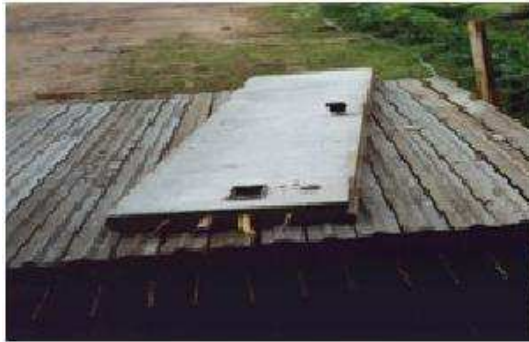
Figura 5. Placa de concreto com aplicação da fibra de bambu.
