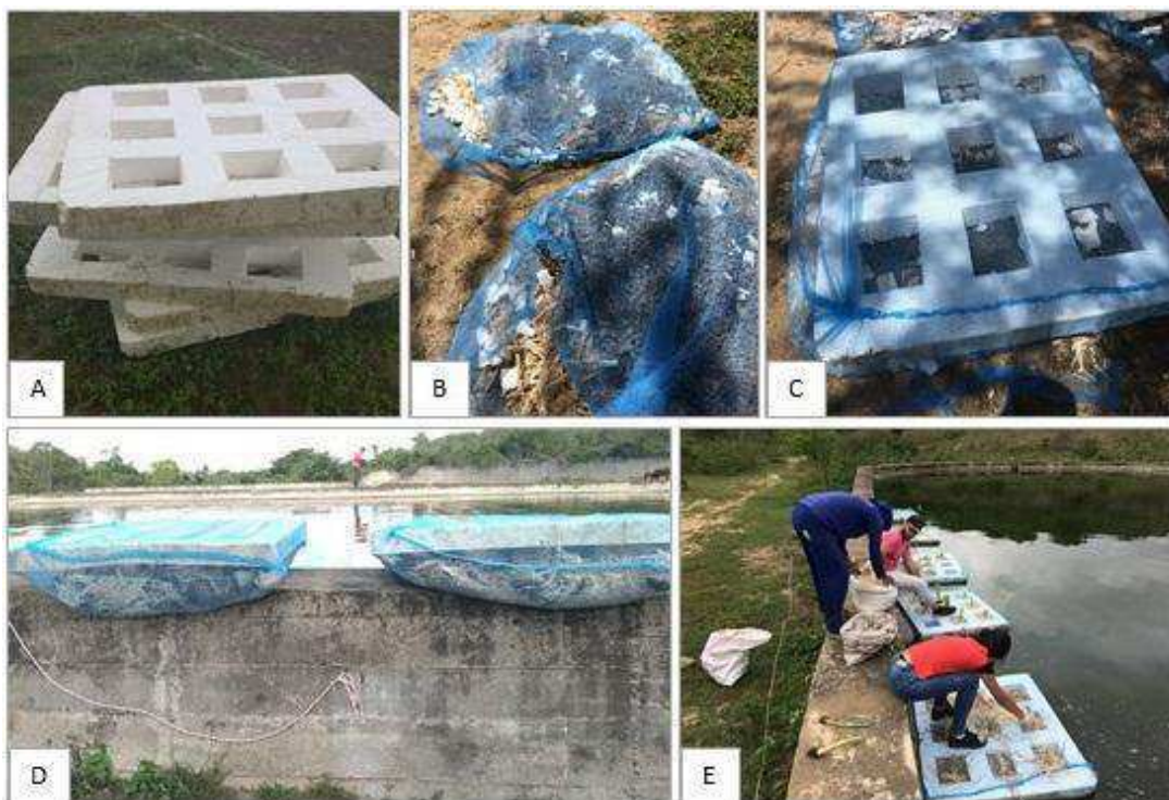
Figura 17 - Construção e montagem dos jardins flutuantes em 2019. A) Placas de EPS. B) Preenchimento da rede com o substrato misto. C) Fechamento da rede. D) Transporte dos jardins para a lagoa e junção das fileiras. E) Complemento do substrato e colocação das plantas. Campina Grande – Paraíba (Brasil)
