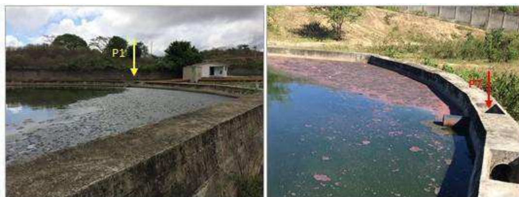
Figura 21 - Acúmulo de espuma na margem esquerda da lagoa anaeróbia em 2019. Campina Grande - Paraíba (Brasil)
