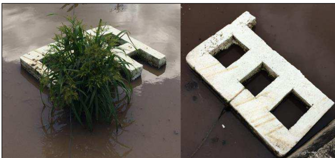
Figura 27 - Falha apresentada pela estrutura de EPS
