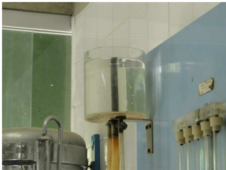
FIGURA 41 - RESERVATÓRIO COM EXTRAVASOR CENTRAL (TUBO PRETO)
