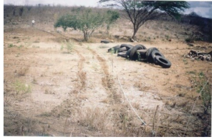
Figura 4. Riscar a curva com chibança e, posteriormente, buscar o ponto mais baixo para rebaixar uma camada de pneu no ponto com mais areia.
