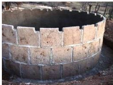
Figura 4. Montagem das placas, lembrando que a fileira superior possui um diferencial de rebai-xamento para acomodar os trilhos da tampa.
