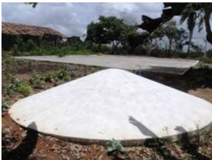
Cisterna de placa utilizando captação de calçadão com 220m 2
