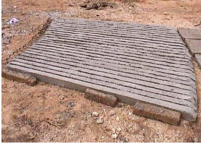
Figura 5. Trilhos para sustentação da tampa de proteção da cisterna.
