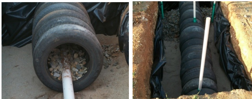
Figura 4. Início do preenchimento do tanque.
