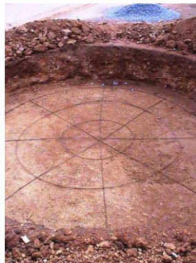
Figura 2. Armação com vergalhão 5/16", para receber massa de concreto na espessura de 10cm.
