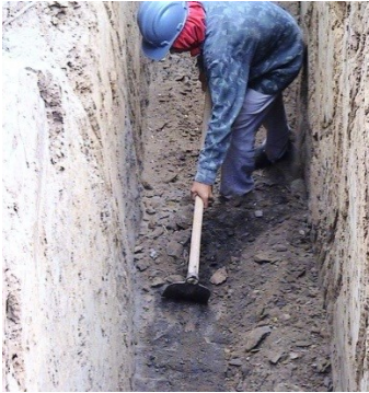
Figura 3. Limpeza no fundo da vala.
