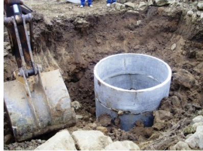
Figura 7. Preenchimento com solo do entorno a cada três anéis, preferencialmente o mais arenoso, para prosseguir a montagem dos anéis sucessivos.
