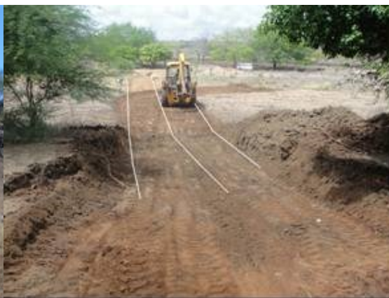
Figura 2. Limpeza com retirada da vegetação do trecho transversal do barramento a ser construído.
