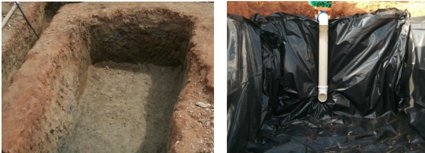
Figura 1. Abertura do tanque evaporímetro, instalação da lona e ligação com a caixa d'água.
