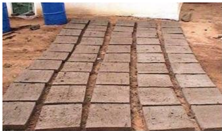
Figura 3. Placas de cimento e areia que devem ser constantemente regadas, preferencialmente em lugares sombreados para permitir uma melhor cura.
