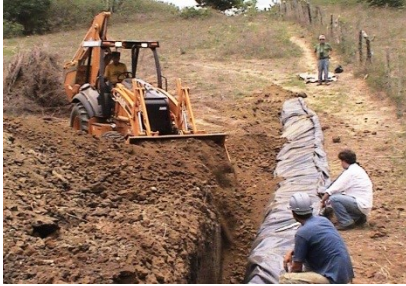
Figura 6. Reaterro da vala em 45 graus.
