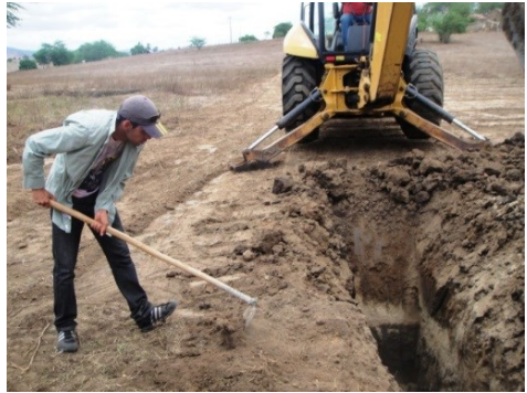
Figura 4. Limpeza no canto da vala para colocação da lona.
