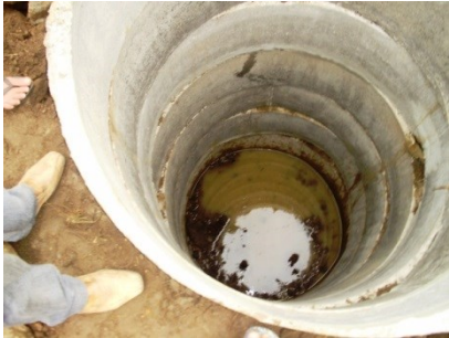
Figura 8. Anéis pré-moldados após a montagem sucessiva.
