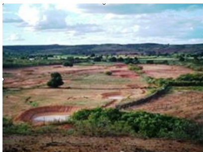
Figura 1. Vista panorâmica da sequência sucessiva de barraginhas, observando a suavidade da declividade do terreno.
