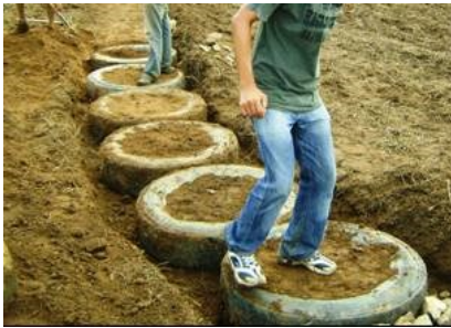
Figura 5. Preenchimento de solo na camada inferior ao nível do solo mais baixo do riacho.
