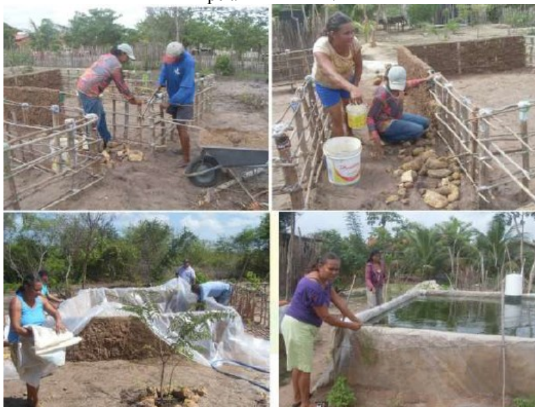
Figura 2. Esquema de fixação de estacas e varas no tanque de 48m 2 .
