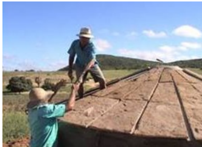
Figura 7. Montagem da cobertura da cisterna com material confeccionado no próprio local.
