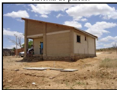
Figura 4. Detalhe dos fundos e da lateral direita da residência, mostrando o aspecto visual do telhado em diagonal.
