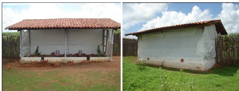
Figura 3. Instalação para criação de aves em alvenari
