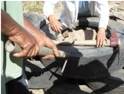
Figura 9. “Grampeando” a vara de ferro para fixar o último pneu no conjunto.
