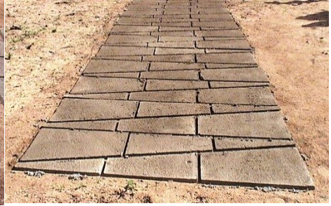
Figura 6. Placas para montagem do forro da tampa da cisterna.
