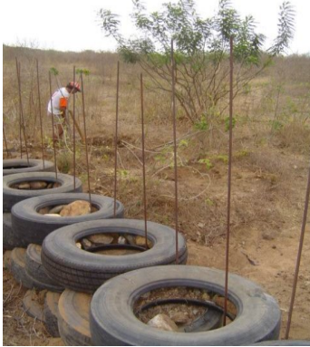
Figura 7. Colocação das varas na face montante do barramento, uma por pneu.
