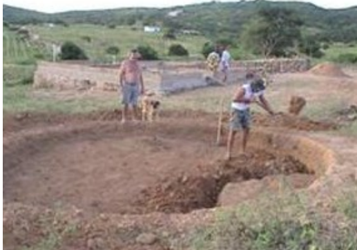
Figura 1. Procedimento de marcar, com estaca e corda, o círculo com raio de 2,5m e iniciar a escavação manual.
