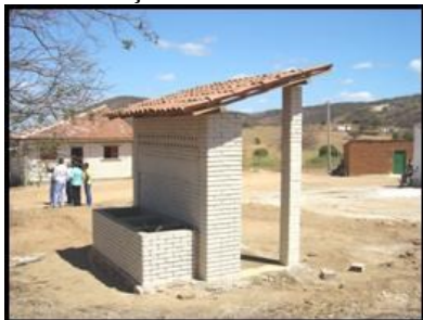
Figura 1. Lavanderia pronta com sistema de tratamento primário de efluentes.
