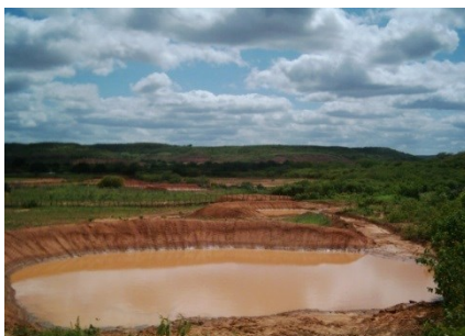
Figura 2. Detalhe de um dos barramentos, com a sua sangria direcionada para o curso de escoamento, onde encontrará outro barramento abaixo.
