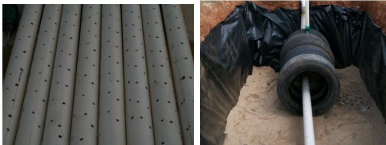
Figura 2. Tubos de PVC perfurados e instalação do tubo e de pneus.
