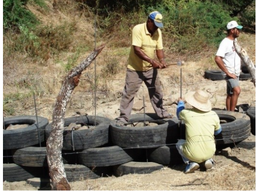
Figura 8. Fixação de varas no solo com uso de marreta.
