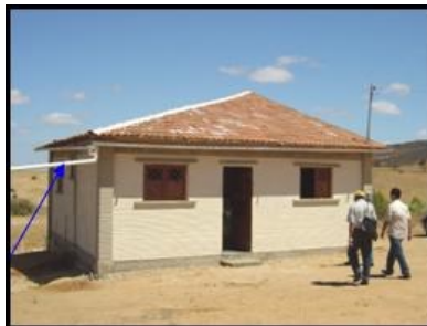
Figura 2. Residência finalizada com sistema de aproveitamento e direcionamento das águas das chuvas para a cisterna de placas.
