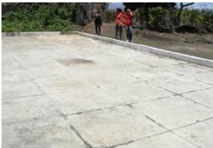
Detalhe da composição de placas formadoras do calçadão com 220m 2
