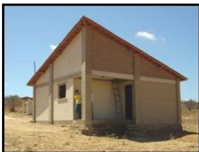
Figura 3. Detalhe dos fundos e da lateral esquerda da residência, mostrando o aspecto visual do telhado em diagonal.
