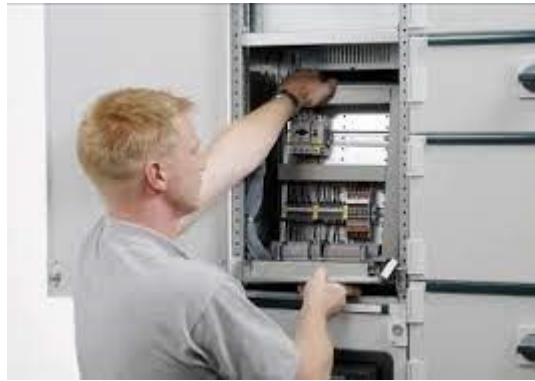
Figura 26 - Painel Elétrico Tipo Fixo e Extraível
