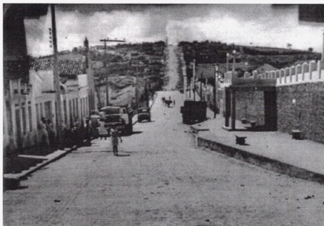
Figura 7: Rua do Comércio – Atual Antônio Gonçalves – 1960. O detalhe a direita da foto e da Praça Central – Atual Praça Souto Maior.
