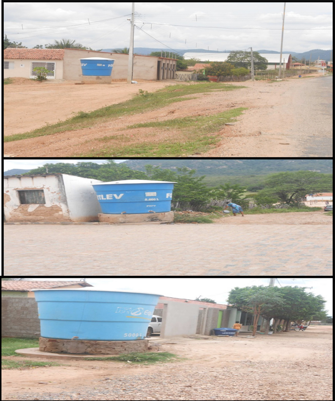
Foto 6 – Caixas d'água construídas na cidade de Triunfo - PB
