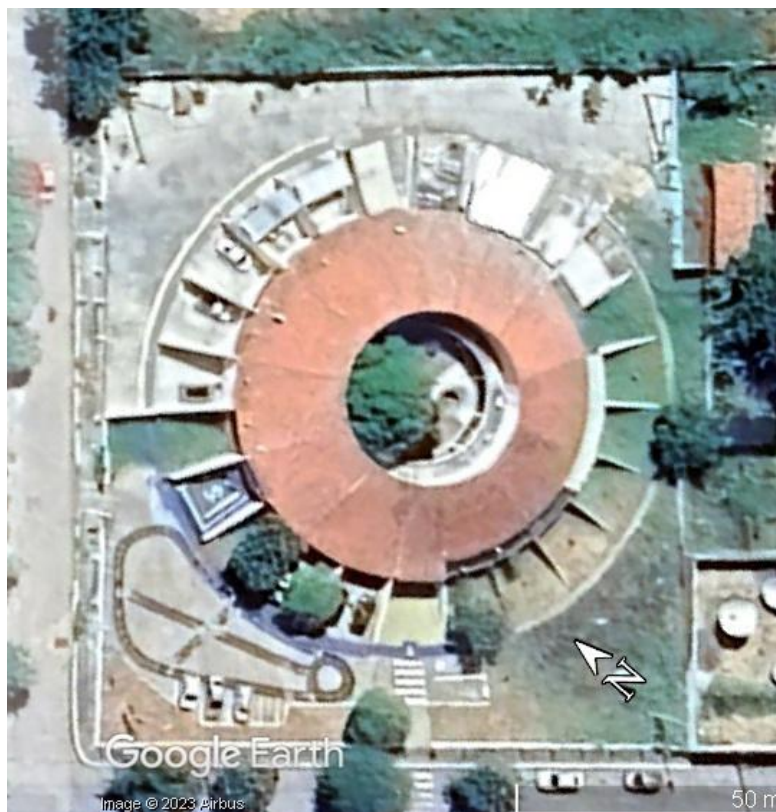
Figura 4 - Representação Via Satélite do Edifício
