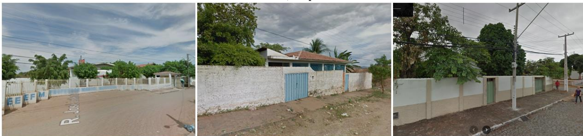
Figura 8 – Estrutura principal até final de 2018, estrutura provisória de 2019 e estrutura provisória de 2020 até o atual momento, respectivamente.
