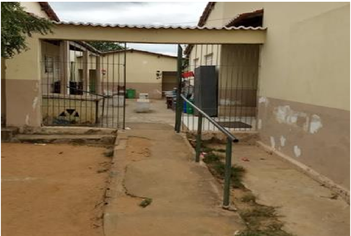
Figura 7 – Rampa de acesso a parte interna escola.
