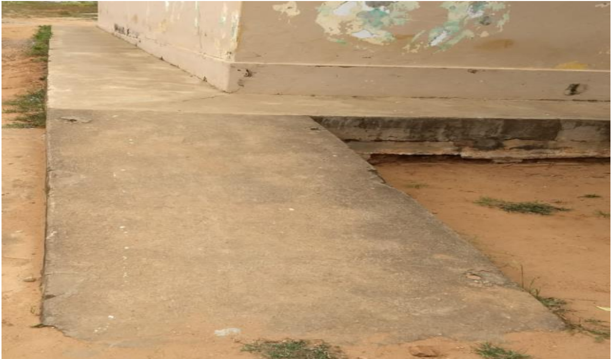
Figura 6 – Rampa de acesso portão 01.
