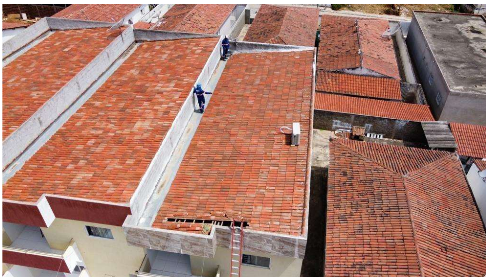
Figura 15 – Telhado da Residência.
