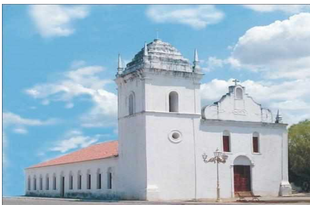
Igreja Nossa Senhora do Rosário dos Pretos
