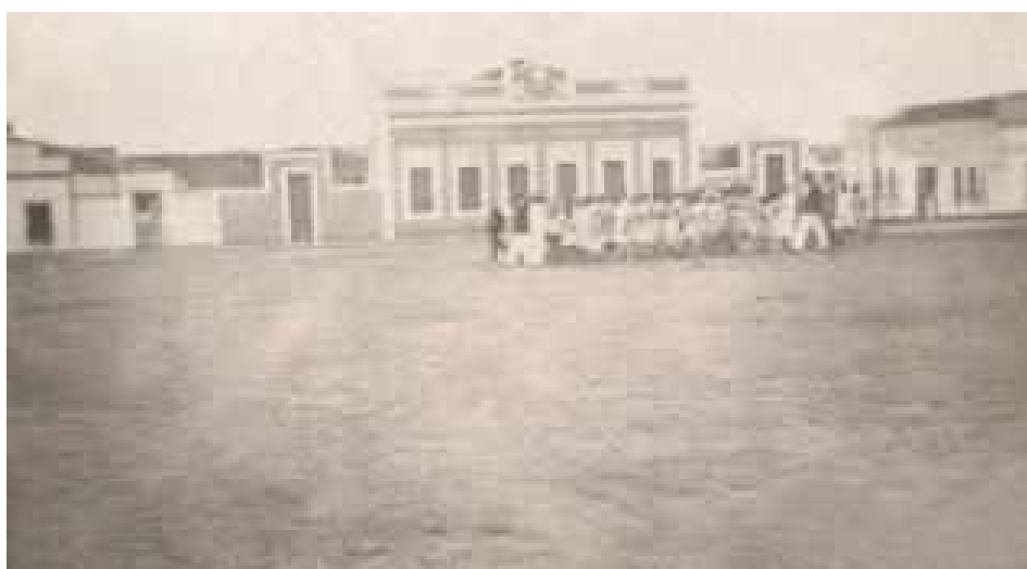
Figura 35: Fachada do Grupo Escolar Joaquim Correia por volta da década de 1930
