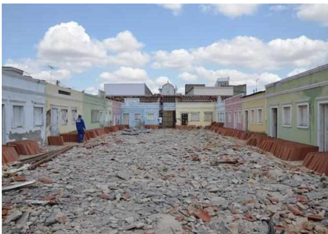
Figura 32: Demolição da parte interna do Mercado durante a reforma
