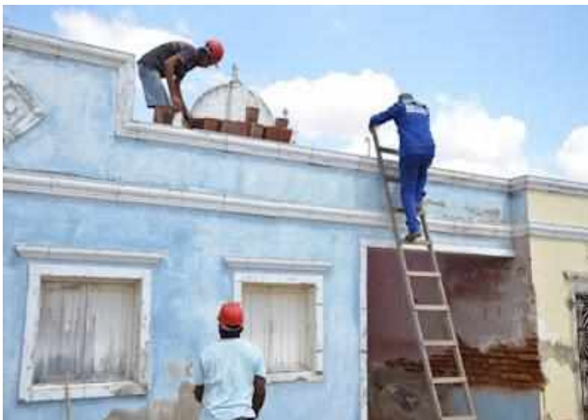
Figura 33: Intervenções na estrutura interna do prédio
