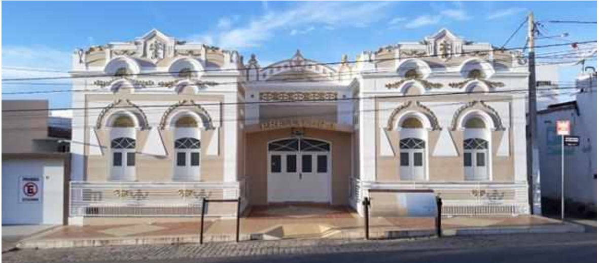
Figura 10: Prédio da Prefeitura Municipal de Pau dos Ferros
