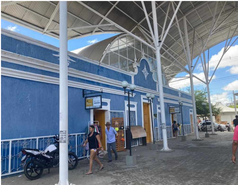
Figura 29: Parte da fachada do Mercado Público em 2023
