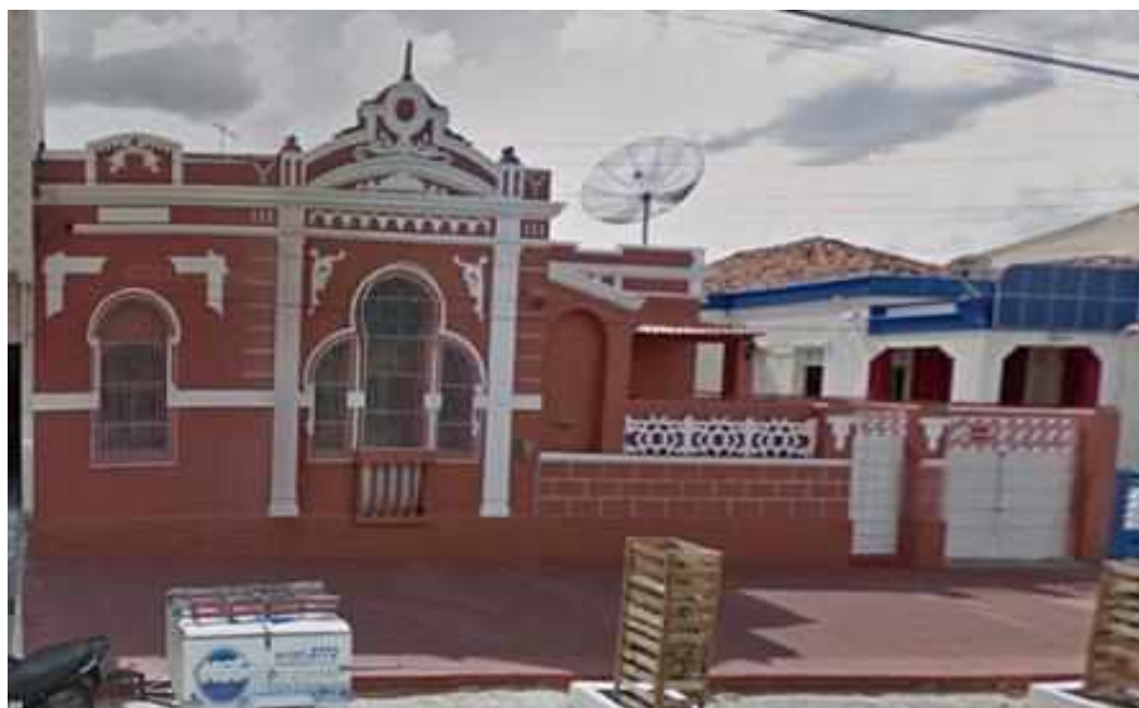
Figura 14: Fachada do “Castelo de Pau dos Ferros”
