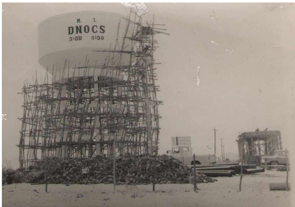
Figura 4: Construção da caixa d'água em 1969
