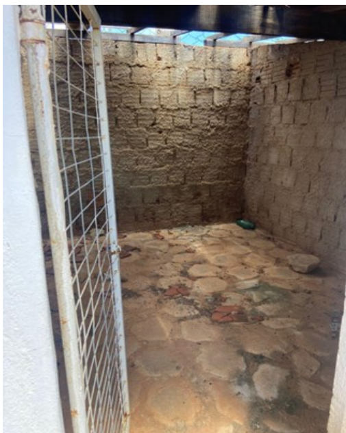
Figura 8 - Interior das salas do antigo Centro
