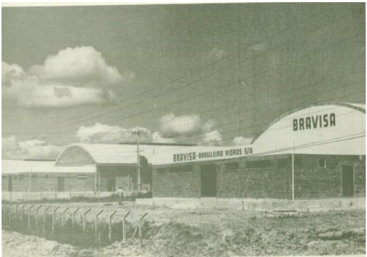
Figura 07: Galpões Multifabris da CINEP
