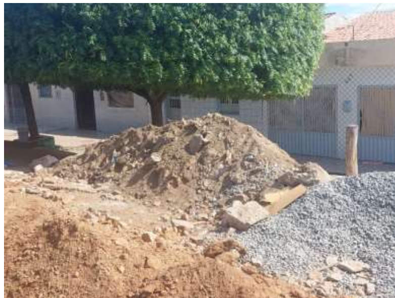
Figure 9 - Obra no bairro Linha de Ferro
