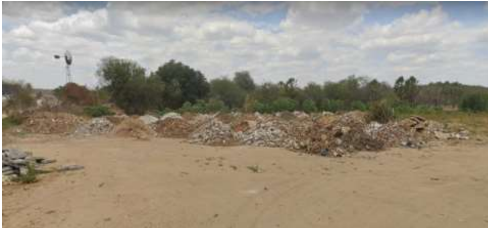
Figure 153 - Local de estocagem temporária dos RCC
