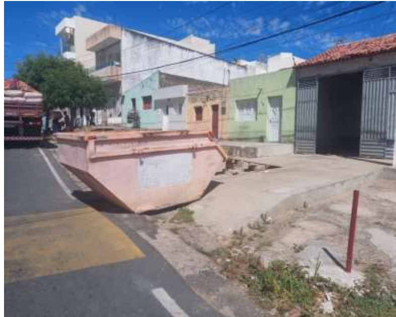
Figure 7 - Obra no bairro Cabo Branco
