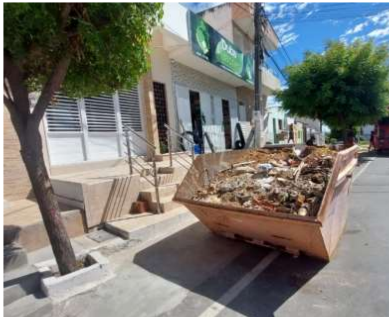
Figure 6 - Obra no bairro Cabo Branco
