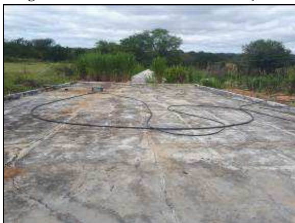
Figura 36 – Cisterna 52.000 litros/Calçadão.
