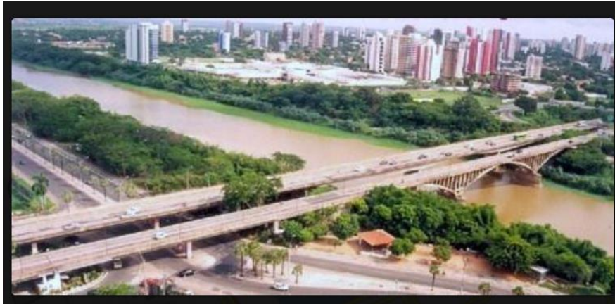
Ponte Juscelino Kubitschek (Licença: Domínio público. Foto: Liminhathe). Disponível em: http://wikimapia.org/160138/pt/Ponte-Juscelino-Kubitschek
