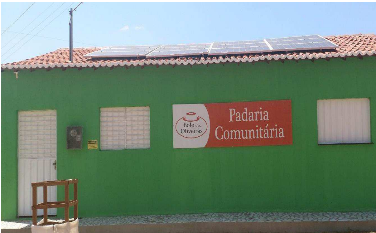
Figura 8. Padaria comunitária na comunidade de Várzea Comprida dos Oliveiras Fonte: Pesquisa de Campo, setembro a novembro de 2018. Comunidade Rural de Várzea Comprida dos Oliveiras, Pombal – PB.
