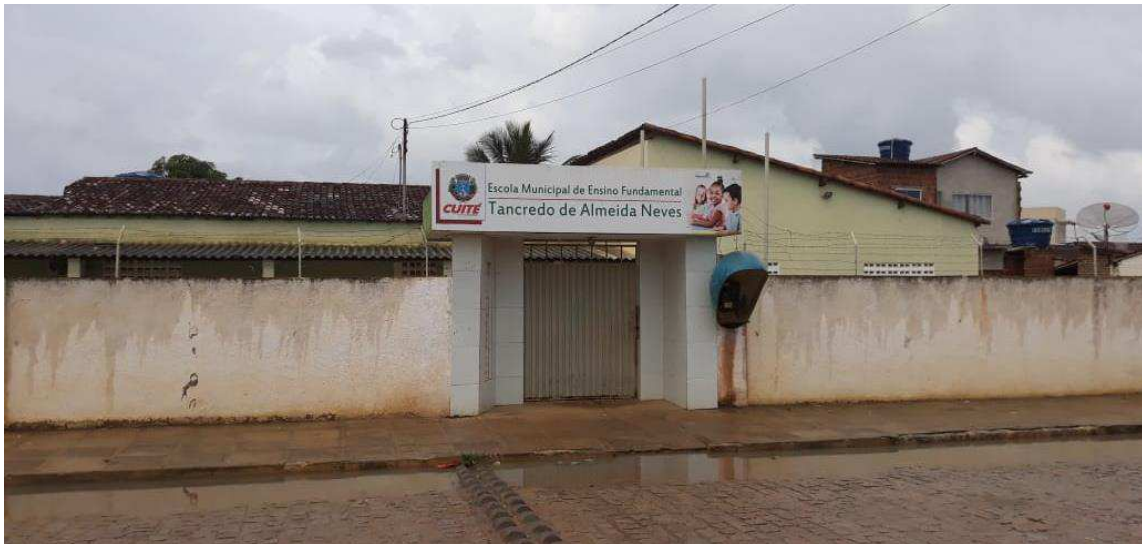
Figura 1 - Fachada da Escola Municipal Tancredo de Almeida Neves, Cuité – PB, 2019.
