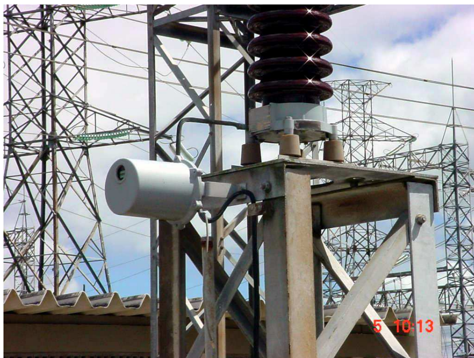
Figura 5.5.2 – Base do Pára-Raios de ZnO.
