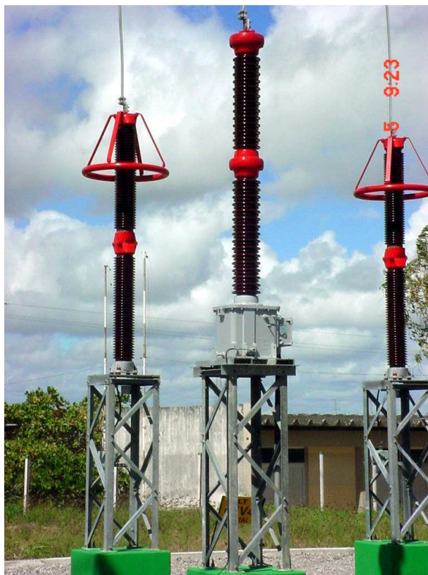
Figura 5.5.1 - Transformador de Potencial e Pára-Raios de ZnO.
