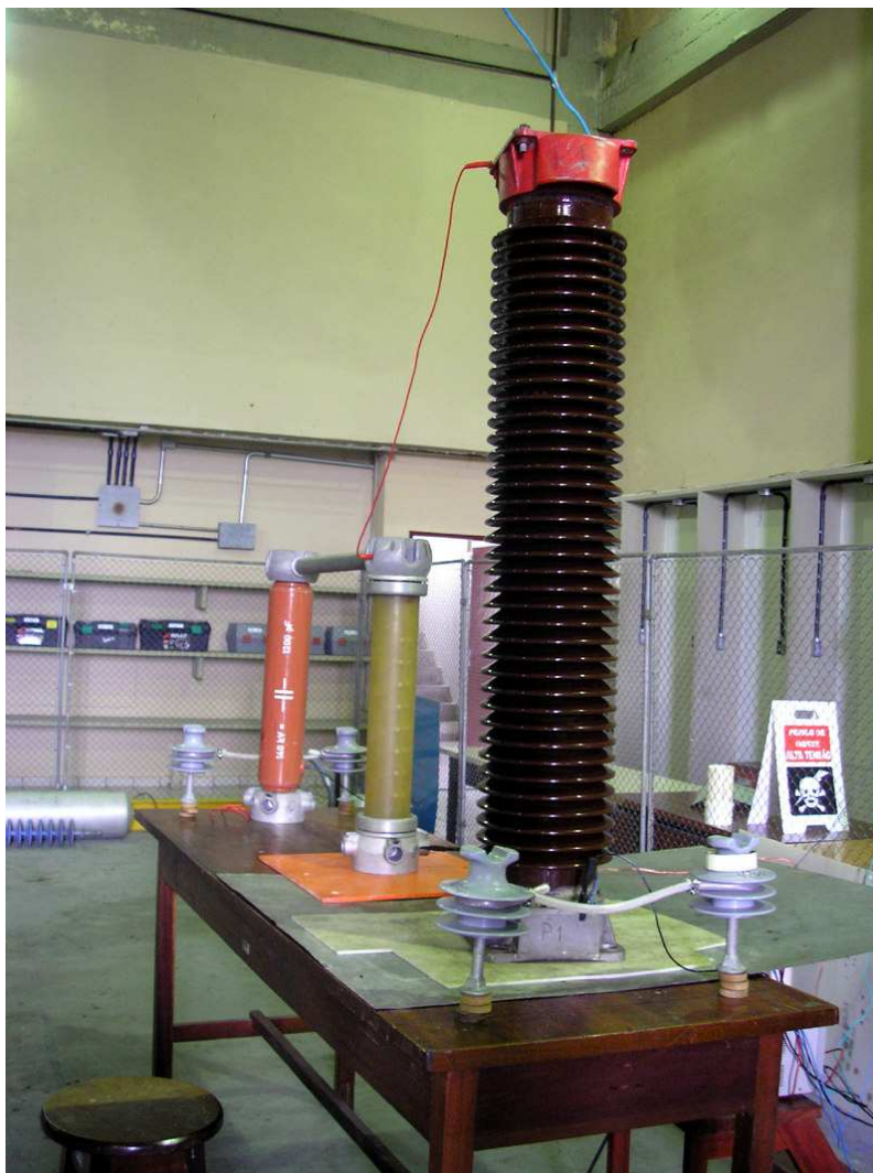
Figura 5.11.5 – Pára-raios utilizado nas medições da corrente de fuga.
