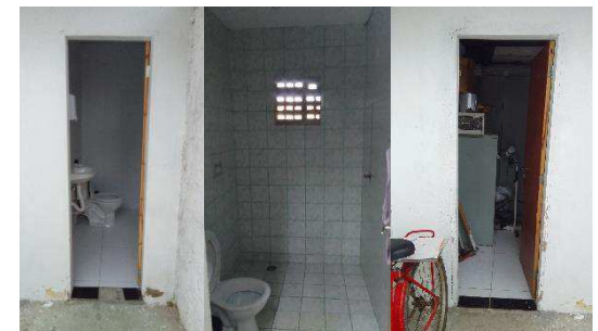
Figura 70: (07,08,09) área de apoio UBS. Fonte: AUTOR, 2023.
