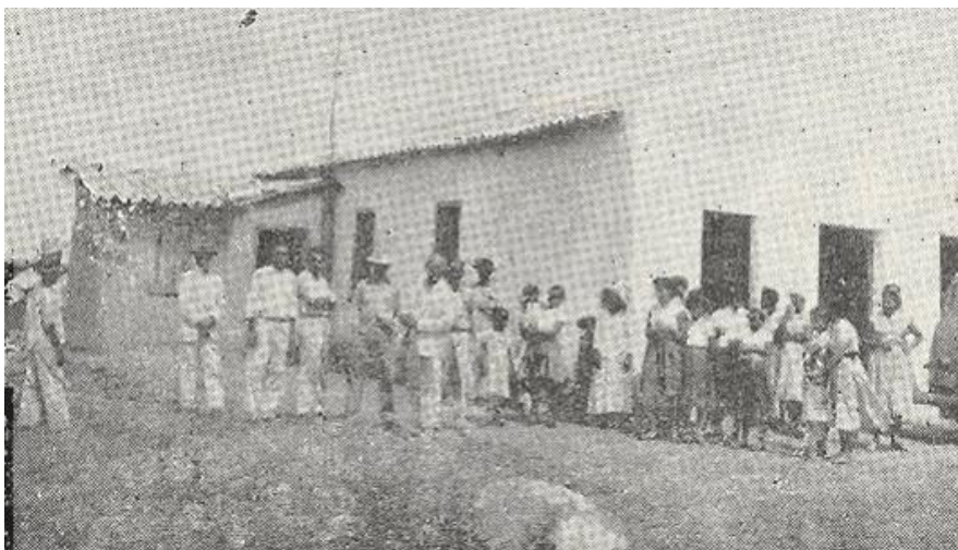
Figura 2: "O povo também constrói as sedes dos seus Centros Sociais de Comunidade, que já são inúmeros no Brasil". Fonte: R. CNER, 1959, p.166
