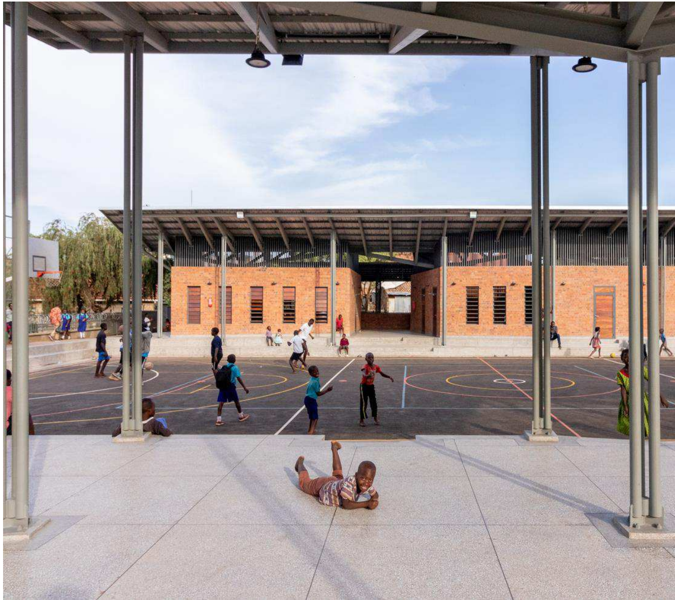
Figura 15: Centro comunitário Kamwokya. Fonte: Archdaily, 2023.
