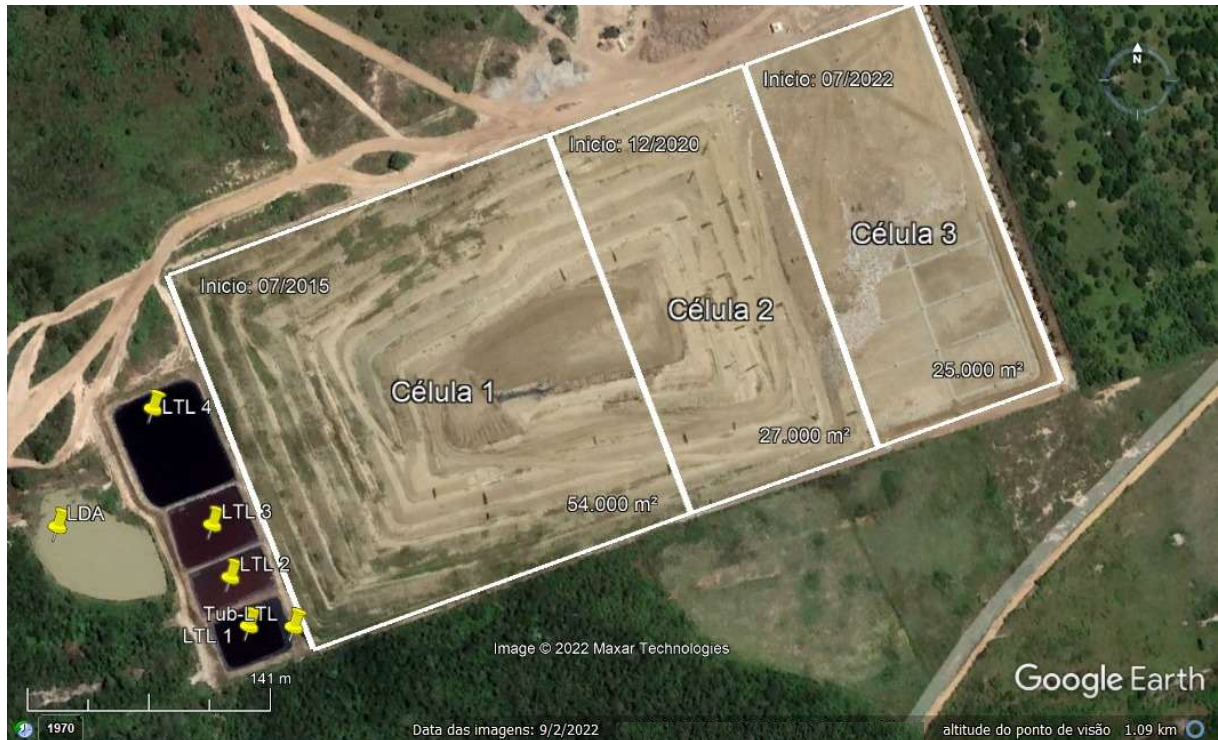
Figura 13 – Vista superior do Aterro Sanitário em estudo
