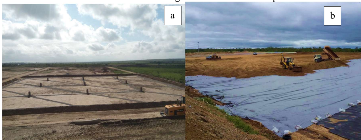
Figura 14 – Aterro Sanitário: (a) Sistema de drenagem de lixiviado; (b) Impermeabilização da camada de base com manta geossintética e solo compactado
