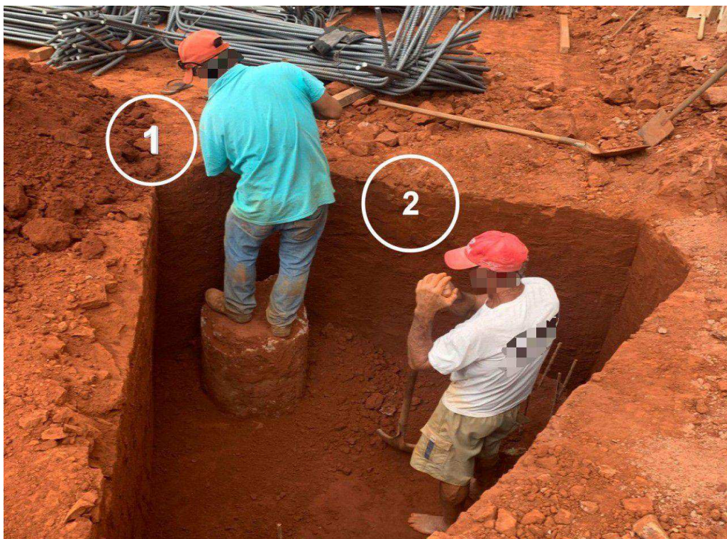
Figura 2 - Trabalhador no canteiro de obras no Centro
