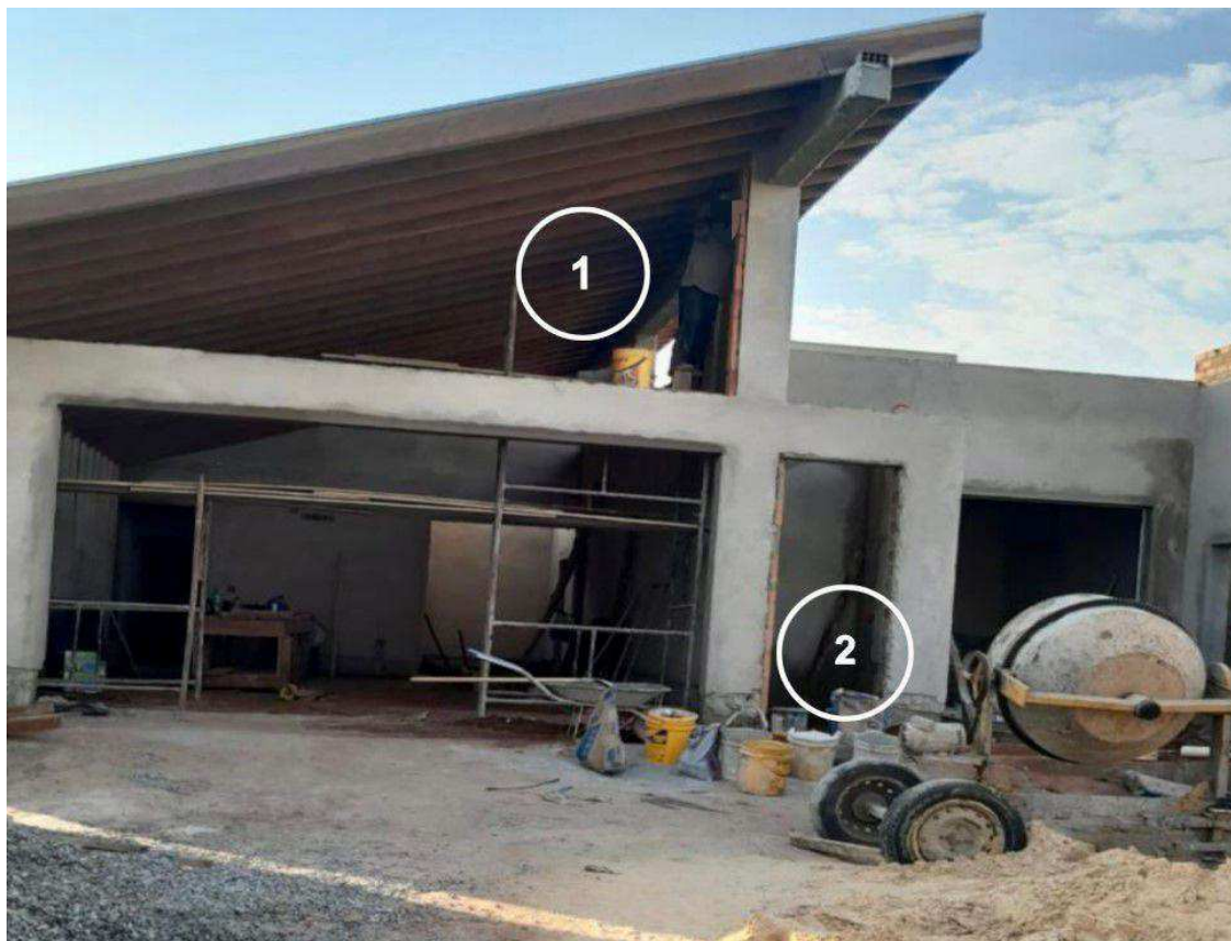
Figura 1 - Canteiro de obra do bairro Monterrey
