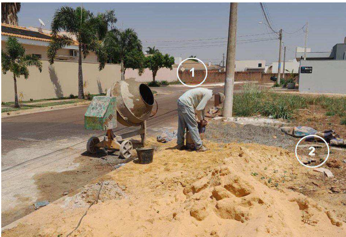
Figura 3 - Trabalhador no canteiro de obras do bairro Barcelona
