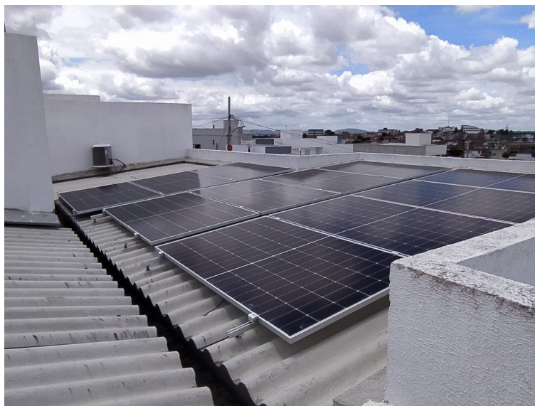
Figura 11: Momento de Acompanhamento de Obra do Projeto Fotovoltaico On Grid
