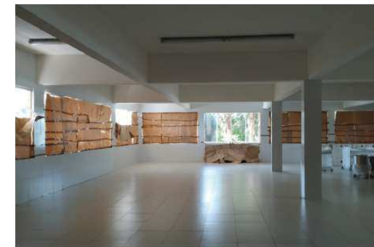
Figura 41: Novo Refeitório RU-Visita técnica NV-UFCG Fonte: Autor, 2021
