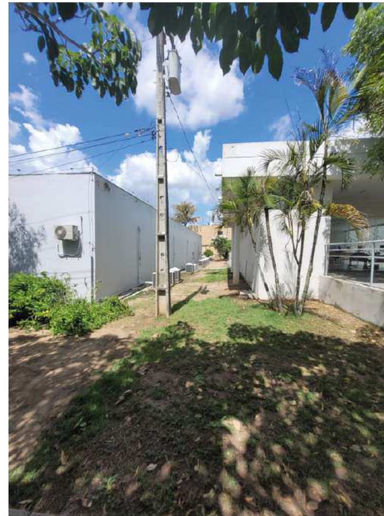
Figura 41: Áreas livres residuais -Visita técnica NV-UFCG Fonte: Autor, 2021
