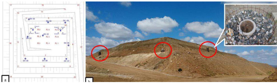
Figura 1. (a) Distribuição dos 9 drenos verticais na Célula 1; (b) Drenos de gases.
