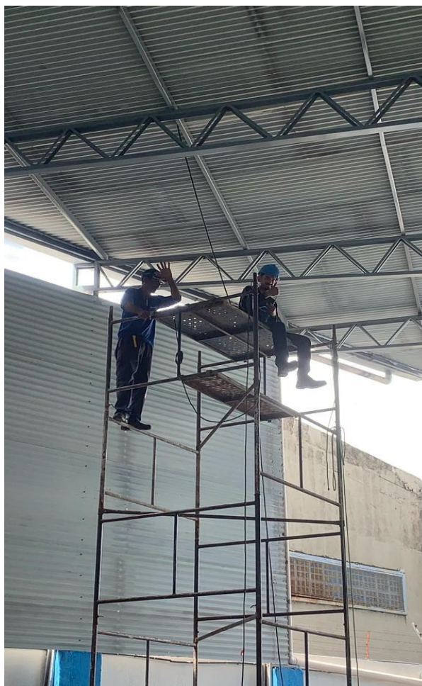
Figura 9 - Colaboradores no trabalho em altura
