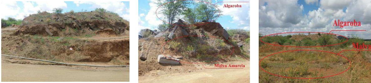
Figura 1. Depósito de resíduos devido à abertura da cava (A); Áreas degradadas cobertas por plantas pioneiras (B) e (C).
