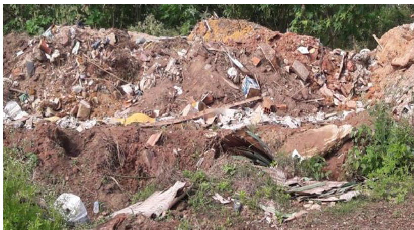
Figura 2. Resíduos de construção e demolição misturados com lixo.
