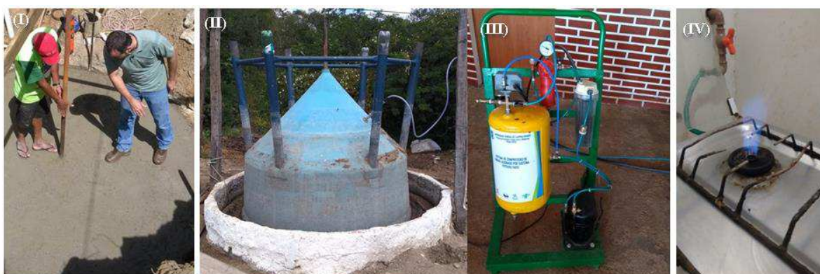
(I) Marcação, escavação e piso; (II) Funcionamento do biodigestor; (III) sistema de compressão instalado; (IV) Acionamento e queima do biogás
