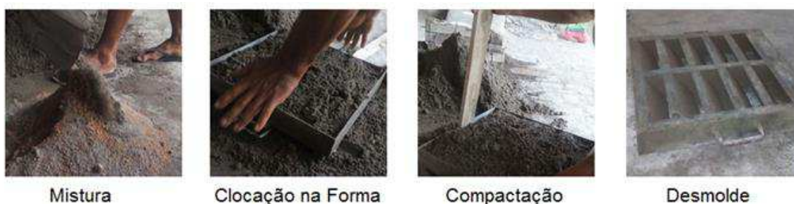
Figura 2. Preparação da argamassa e montagem da peça.
