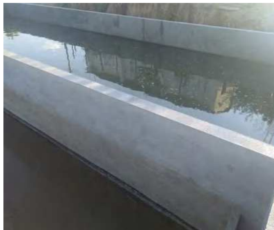
Figura 8 - Fase 01 Leitos drenantes cheios
