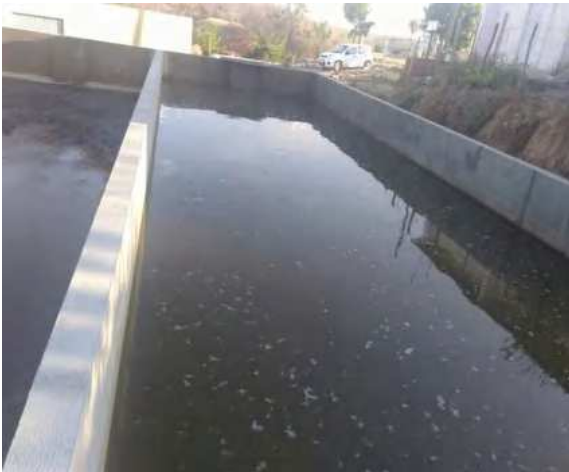
Figura 7 - Fase 01 Leitos drenantes cheios
