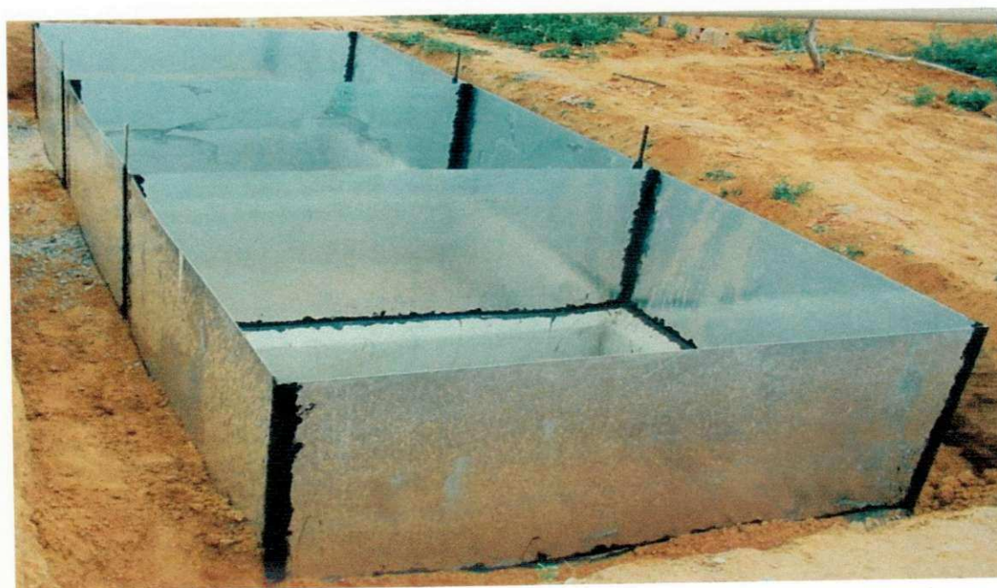
Fig. 3.2. Detalhes da construção dos lisímetros de drenagem, Petrolina – PE.
