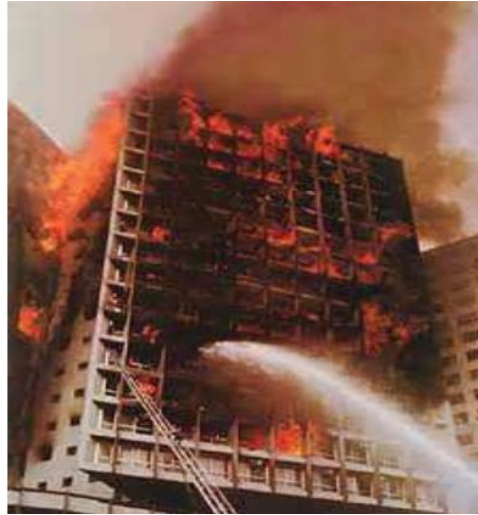
Figura 7- Incêndio no edifício Joelma
