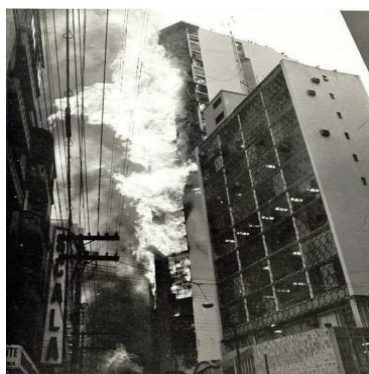
Figura 5- Incêndio no edifício Andraus
