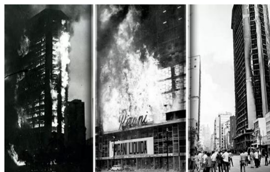
Figura 6- Incêndio no edifício Andraus
