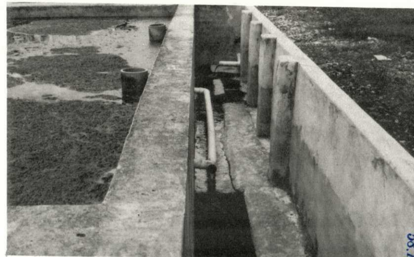
FIGURA 5.3 - DISPOSITIVO DE SAIDA DO EFLUENTE
