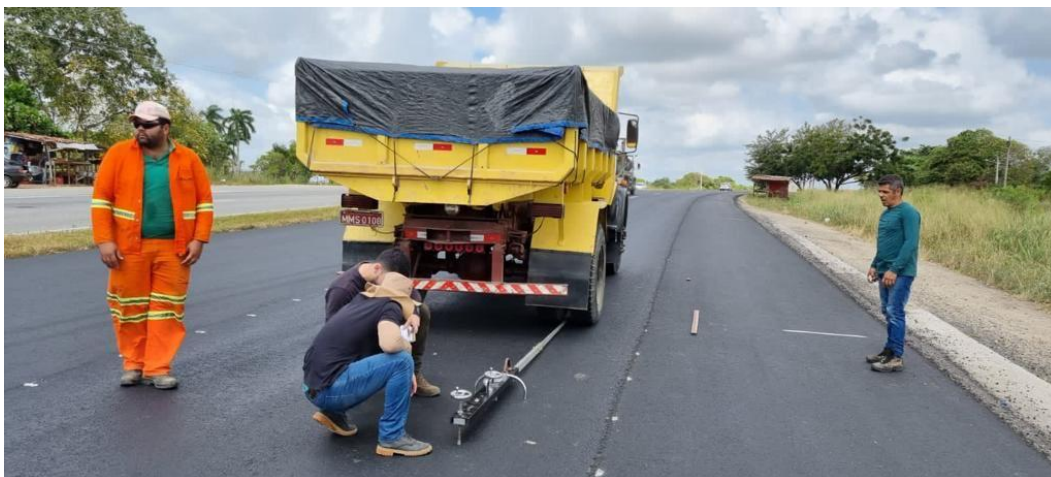
Figura 22 - Posição da viga Benkelman durante levantamento deflectométrico
