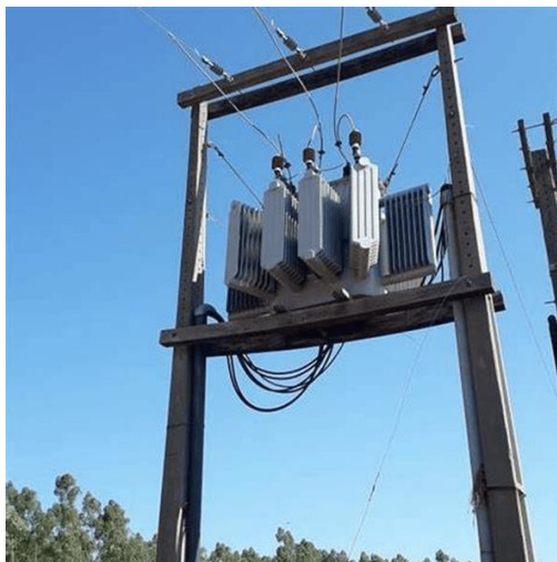
Figura 2 – Subestação aérea.
