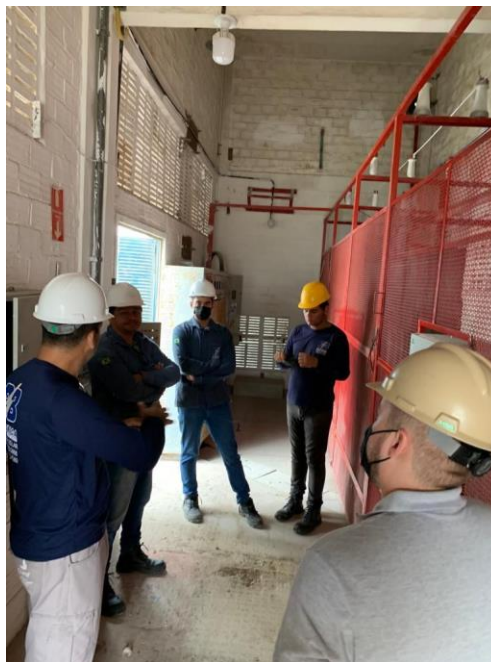
Figura 11 – Manutenção em subestação abrigada realizada pelo estagiário e a equipe da empresa
