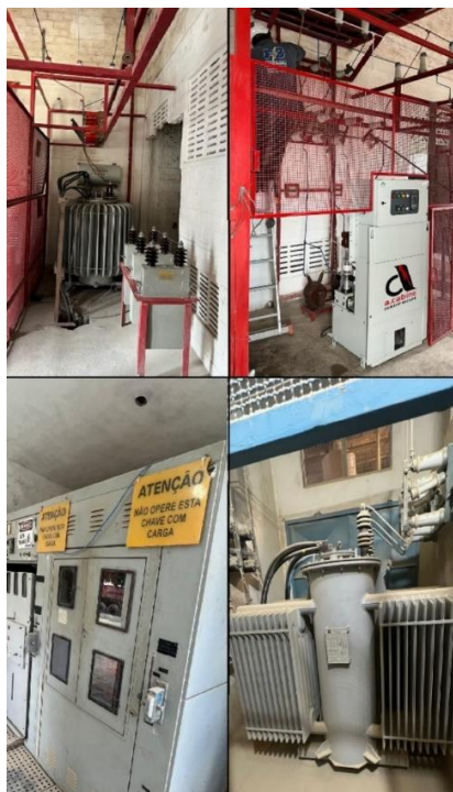
Figura 12 – Fotografias realizadas durante manutenções em subestações.
