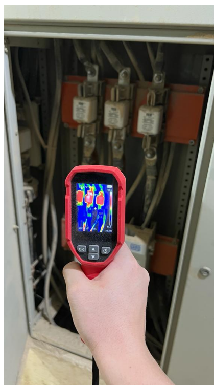
Figura 13 – Inspeção termográfica realizada pelo estagiário.
