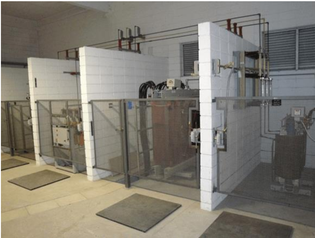
Figura 4 – Subestação abrigada.
