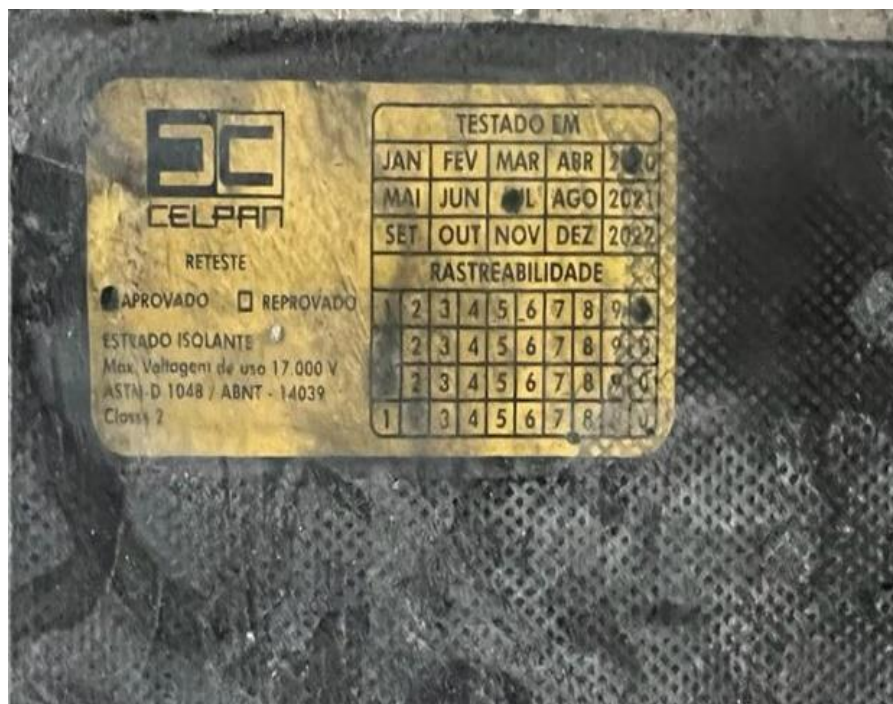
Figura 7 – Tapete isolante de 17kV.
